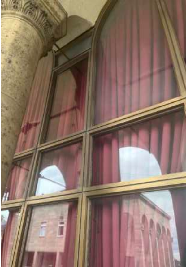
Fassade mit messingfarbenen Zierleisten aus Aluminium
