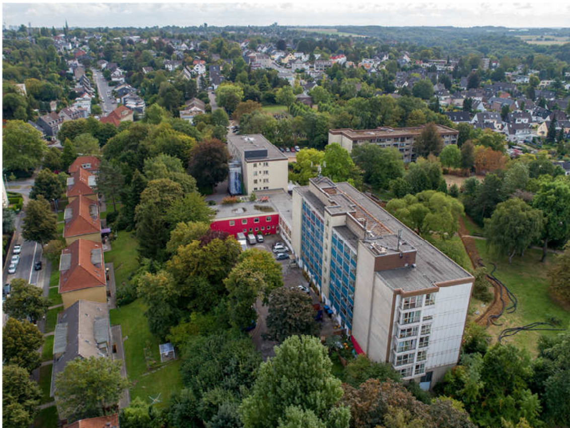
Abbildung 1: Haus Gracht vor Beginn der Baumaßnahme
