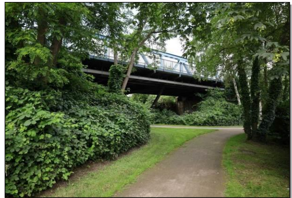
Bild 6: Der von der Moritzstraße führende Fußradweg trifft südlich der Brücke auf den zur Hauskampstraße führenden Teil des „Styrumer Damms“.
