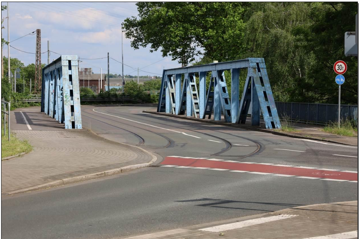
Bild 2: Sicht auf die Brücke Richtung Südosten. Rechts der Abzweig Moritzstraße.
