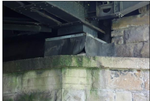
Bild 12: Detail des westlichen Brückenlagers (vgl. Bild 10).
