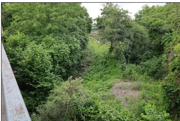
Bild 7: Sicht von der Brücke Richtung Nordwesten auf das zu den aktiven Gleisen der Bundesbahn führende Gleis.
