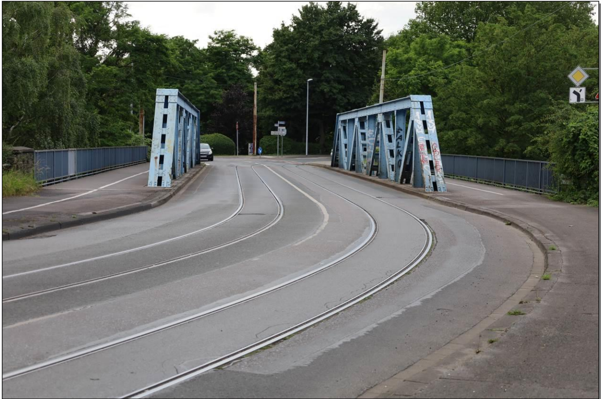
Bild 1: Sicht über die Brücke Richtung Nordwesten.
