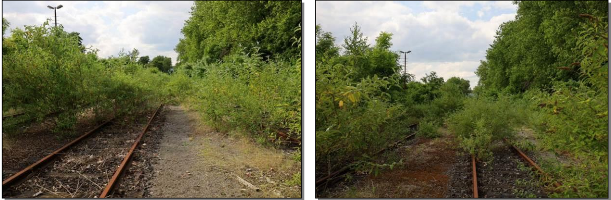
Bild 17 u. 18: Gleisbereiche vor der Böschung zur Hauskampstraße.
