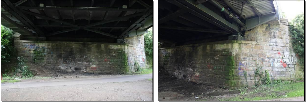
Bild 9 u. 10: Brückenfundament am Fuß- und Radweg.
