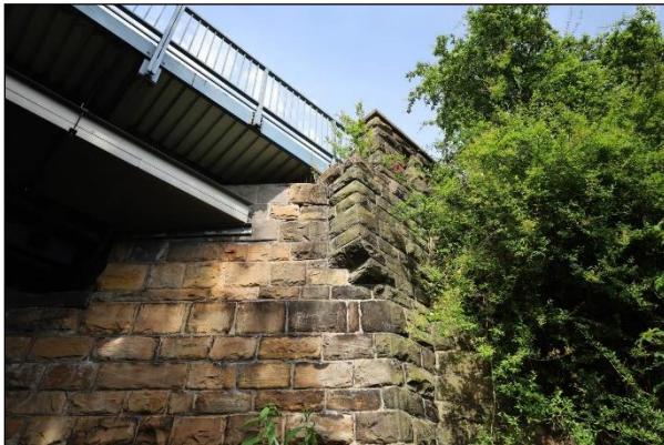
Bild 11: Teilansicht des östlichen Brückenfundaments.
