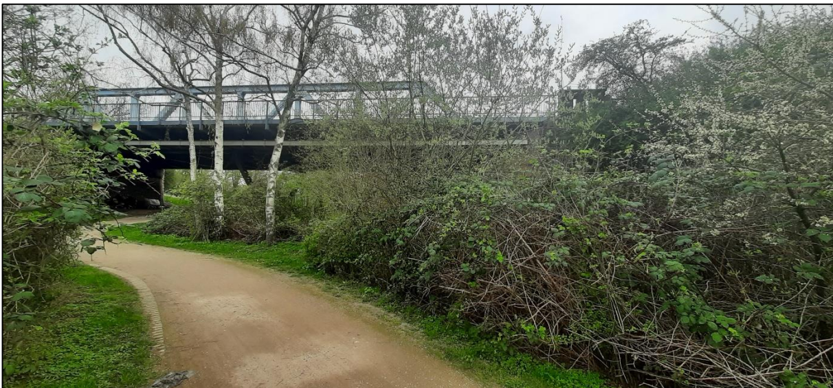
Foto 9 Blick in nördlicher Richtung auf den Gebüschsaum entlang der Bahnstrecke Böschungsbereich, der im Rahmen der Arbeiten im Umfeld der Brücke sowie in südlicher Richtung freigestellt werden muss, dies gilt auch für die zwei am Weg gelegenen Birken (1x 2-stämmig, 1x 1-stämmig)
