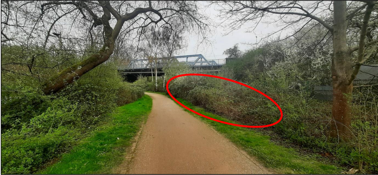
Foto 10 Blick in nördlicher Richtung auf das Brückenbauwerk, die erforderliche Baustelleneinrichtungsfläche (rote wird so erstellt, dass die beiden Bäume die beiden Bäume im Vordergrund erhalten bleiben
