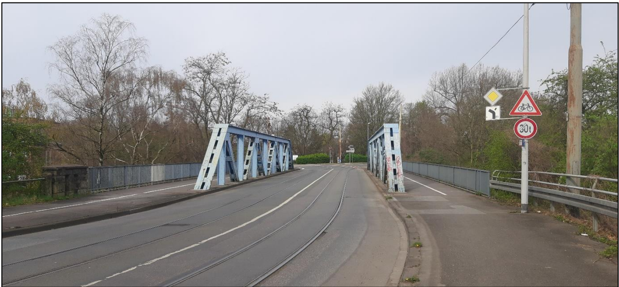
Foto 2 Blick in nordwestlicher Richtung auf die Hauskampstraße mit dem Brückenbauwerk (eigene Aufnahme: 22.03.2024)
