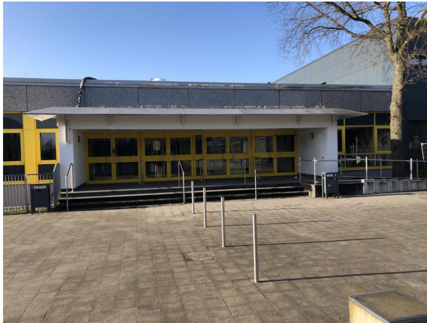
Demontage Attika-Fassadenplatten inkl. KMF-Dämmung
