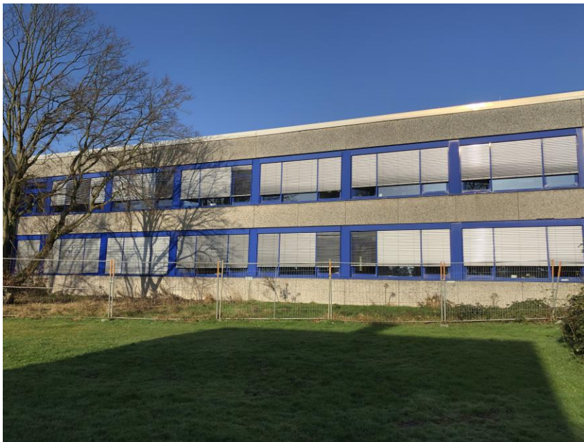
Demontage Fassadenplatten inkl. KMF-Dämmung
