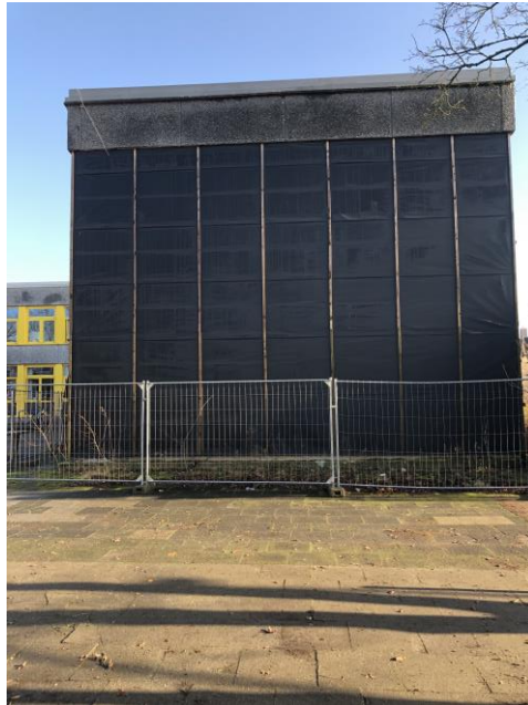
Demontage Attika-Fassadenplatten inkl. KMF-Dämmung Demontage provisorische KMF-Dämmung inkl. Lattung u. Folie
