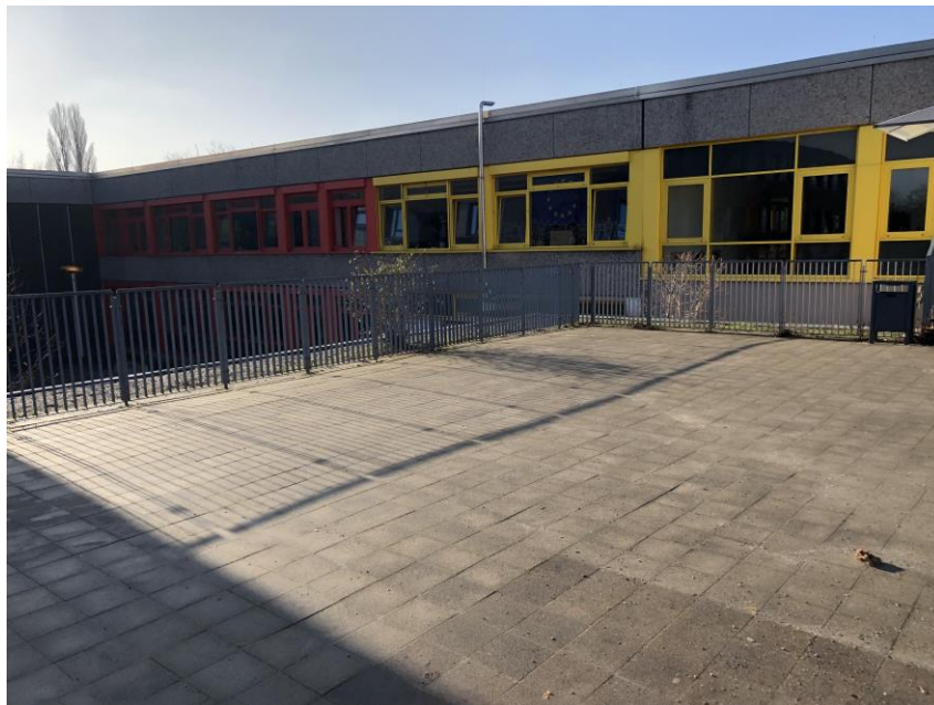
Demontage Fassadenplatten inkl. KMF-Dämmung
