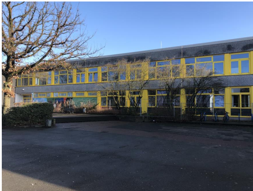
Demontage Fassadenplatten inkl. KMF-Dämmung
