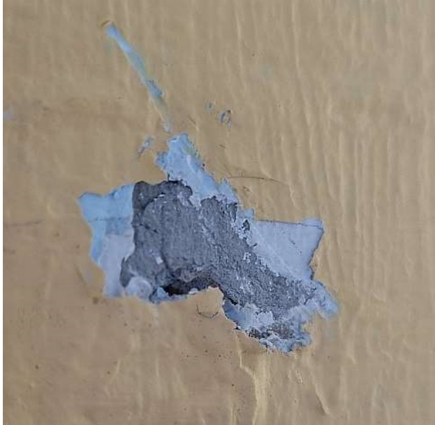
(Bsp.-Foto Altanstrich mit Feinspachtelung auf Beton)
