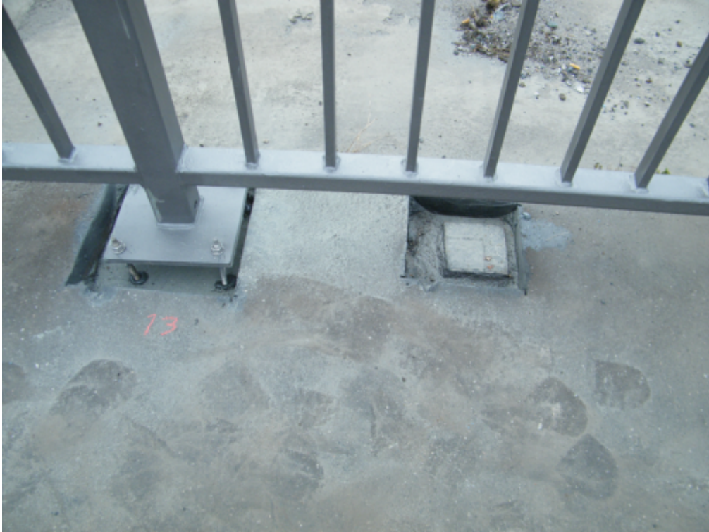
Abbildung 3: Geländerankerplatten alt und neu
