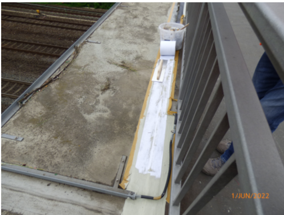
Abbildung 6: Fuge hor. Berührungsschutz
