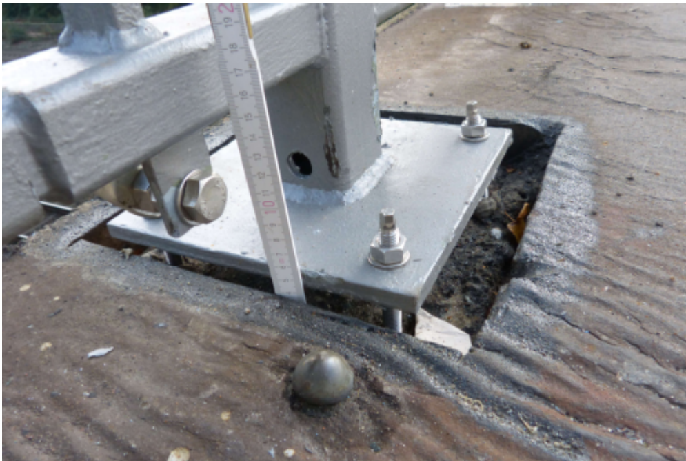
Abbildung 4: neue Geländerankerplatte
