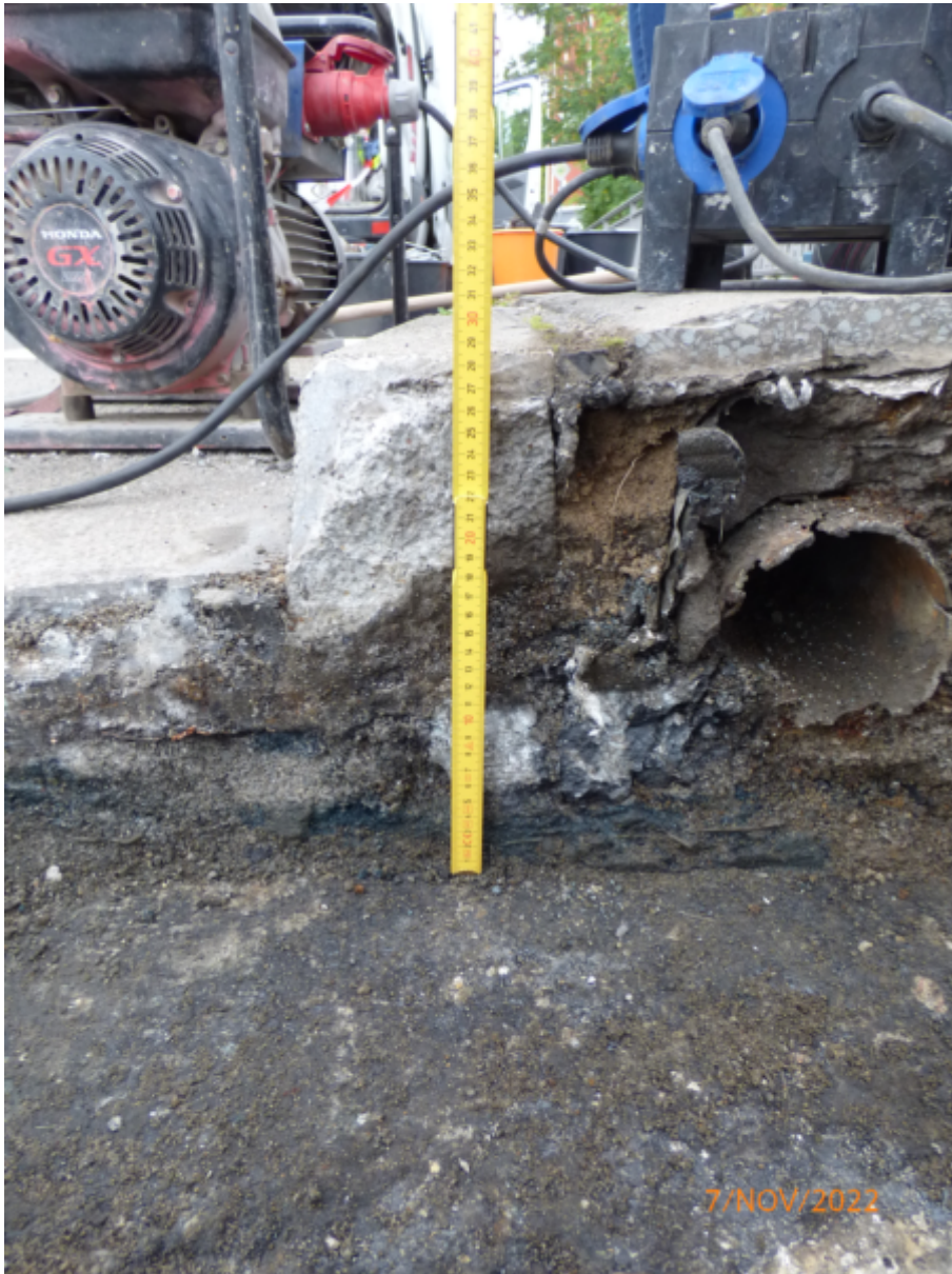
Abbildung 8: Aufbau Mittelfuge
