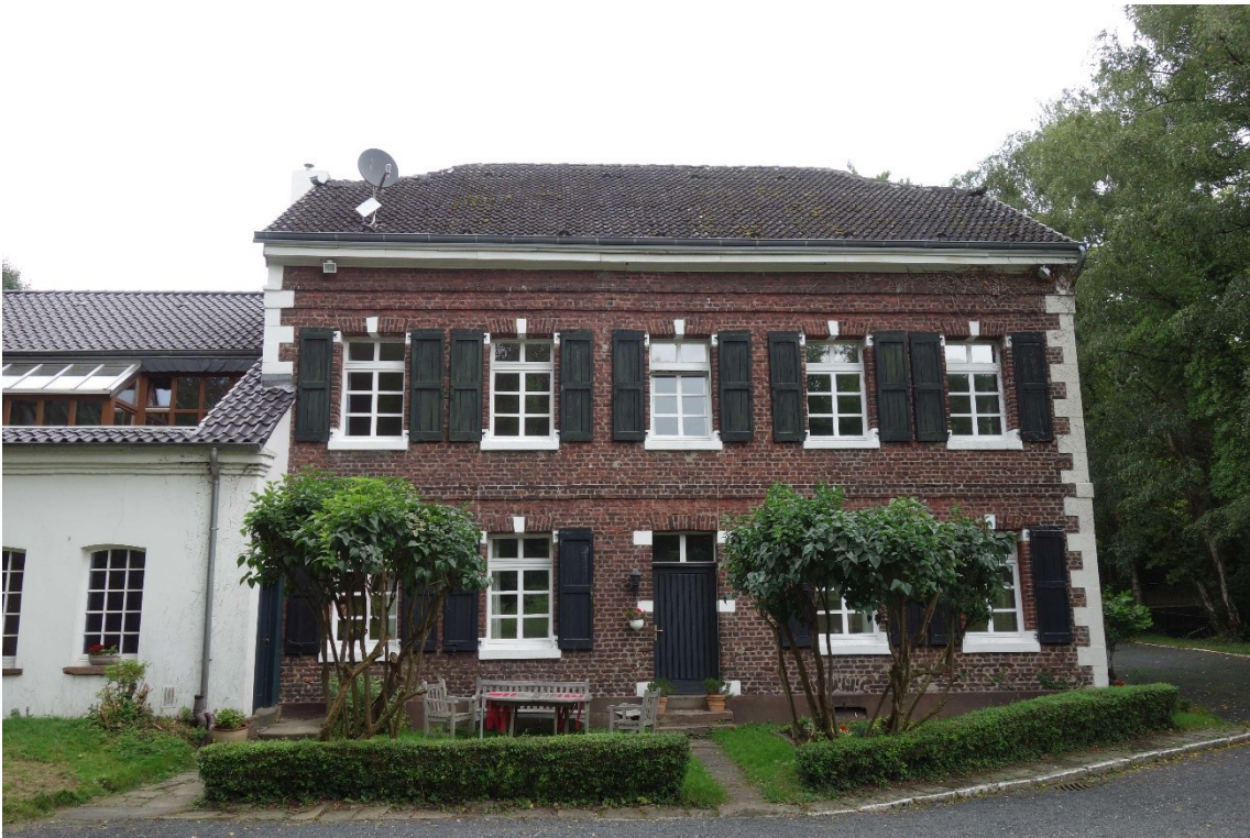
Mülheim an der Ruhr, Walkmühlenstraße 6, Gutshaus der ehem. Wetzmühle, südliche Traufseite, Foto: Nadja Fröhlich (NF), LVR-ADR, 2021.
