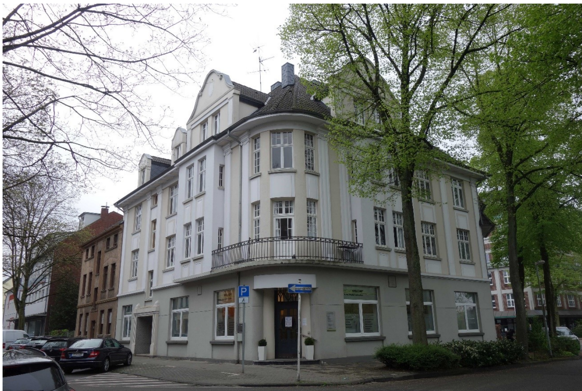
Mülheim an der Ruhr, Ulmenallee 24/Wissollstraße 3, Wohn- und Geschäftshaus, Nordostseite, Foto: Nadja Fröhlich (NF), LVR-ADR, 2022.
