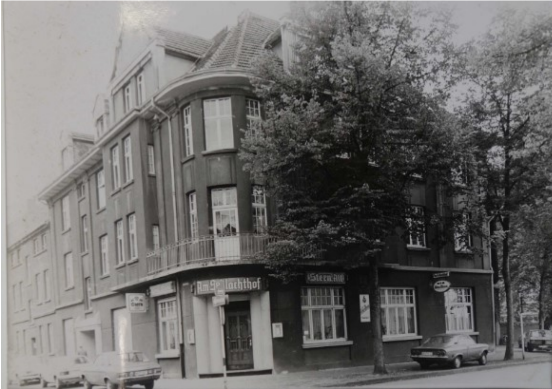
Mülheim an der Ruhr, Wohn- und Geschäftshaus Ulmenallee 24/Wissollstraße 3, historisches Foto aus dem Jahr 1978 mit bauzeitlichen Sprossenfenstern im Erdgeschoss, Foto: Stadtarchiv Mülheim an der Ruhr.
