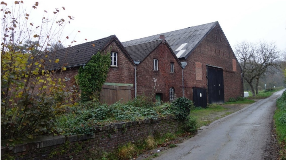
Mülheim an der Ruhr, Saalsweg 11, Stallgebäude und Giebel der anschließenden Scheune, Südseite, Foto: NF, LVR-ADR, 2021.
