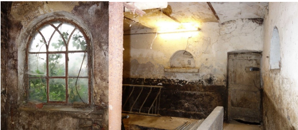
Stallgebäude, Detail Sprossenfenster (links) und preußische Kappendecke, Einbauten, Lichtnische, Brettertür (rechts), Fotos: NF, LVR-ADR, 2021.
