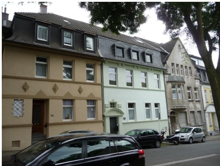
Mülheim an der Ruhr, Oberstraße 76-70, Straßenansicht, Foto: NF, LVR-ADR, 02/2021.
