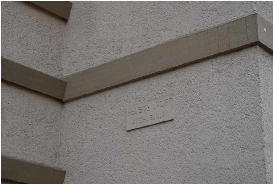
Mülheim an der Ruhr, Oberstraße 76, Detail, Tafel dokumentiert Namen der Architekten, Foto: NF, LVR-ADR, 02/2021.
