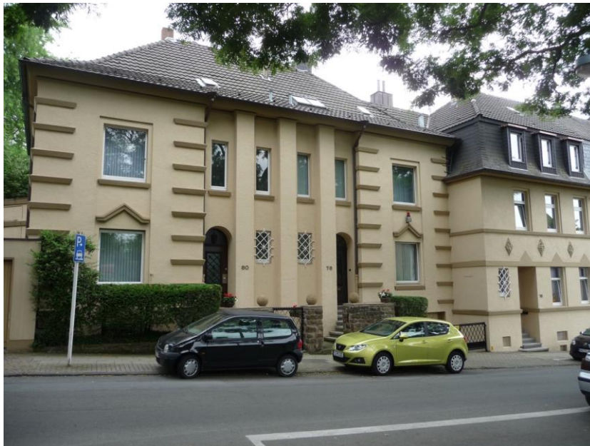
Mülheim an der Ruhr, Oberstraße 76-80, Straßenansicht, Foto: NF, LVR-ADR, 02/2021.
