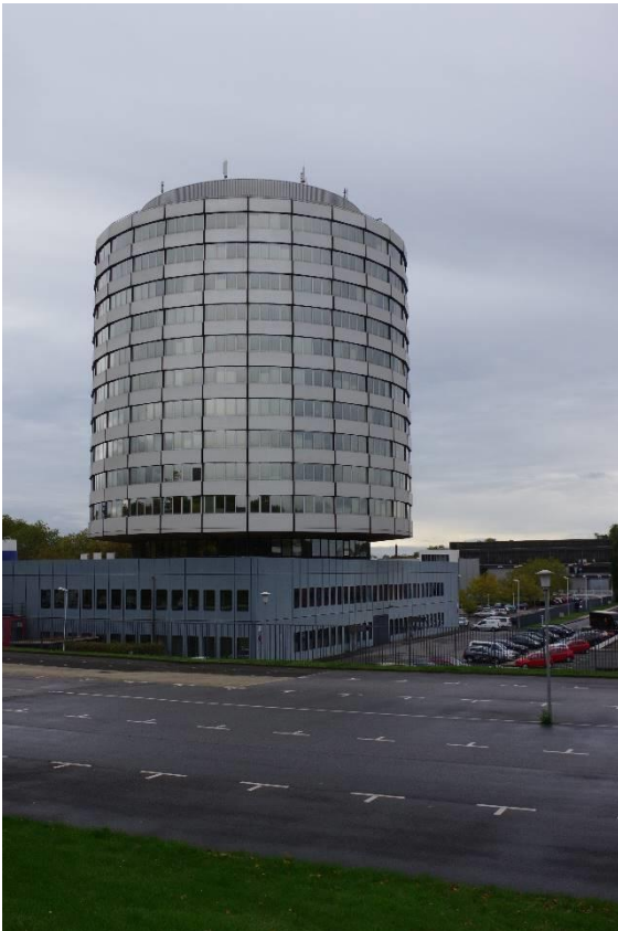
Abb.3: KWU-Gebäude Rückseite, Ansicht von der Mellinghofer Straße, Foto: Jakob Scheffel, LVR-ADR, 2019
