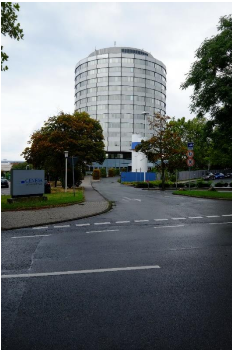
Abb.2: KWU-Gebäude und Einfahrt, Ansicht von der Zinkhüttenstraße, Foto: Rasmus Radach (RR) LVR-ADR, 2019
