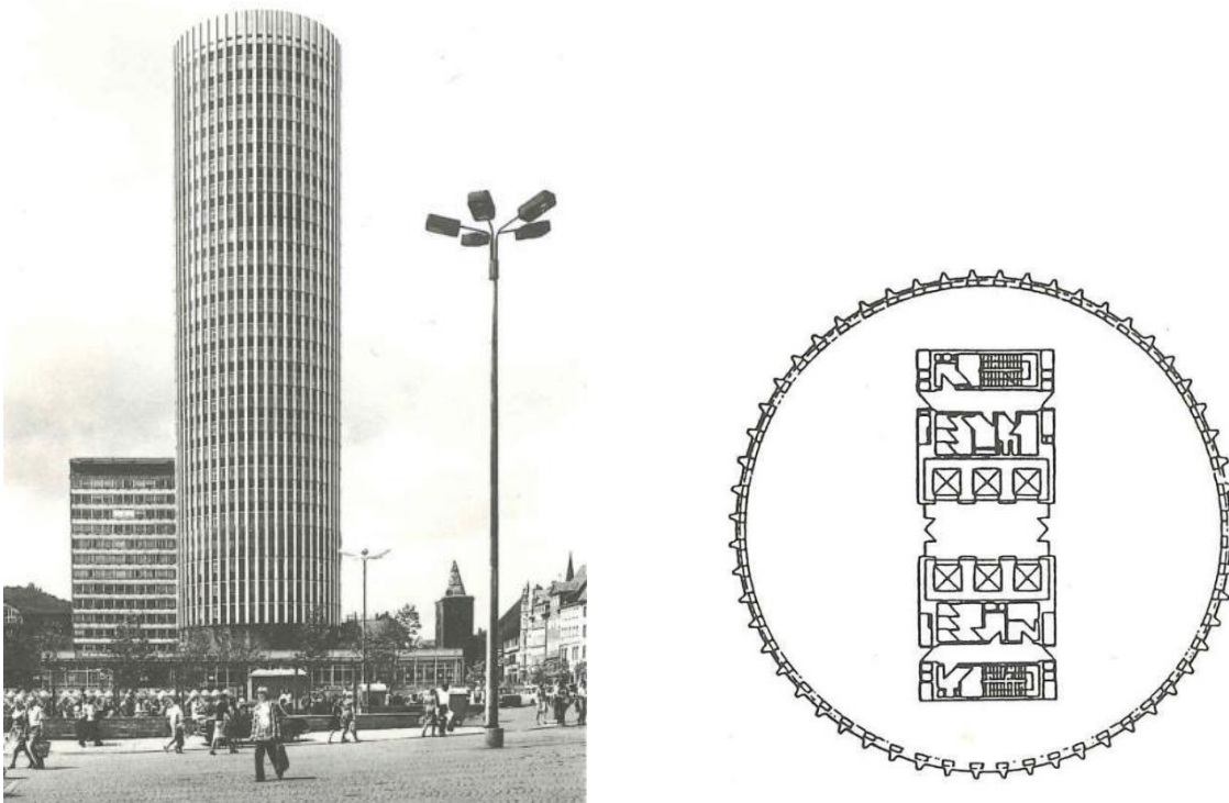
Abb.12: Jentower Ansicht 1982 und Grundriss
