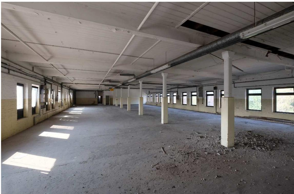
**Abb. 23: Neues Fabrikgebäude (3), 3. Obergeschoss, Großraum mit brettverschalter Holzdecke auf Mittelstützen und Trägern, Foto: LVR-ADR, Rasmus Radach, 2019**
