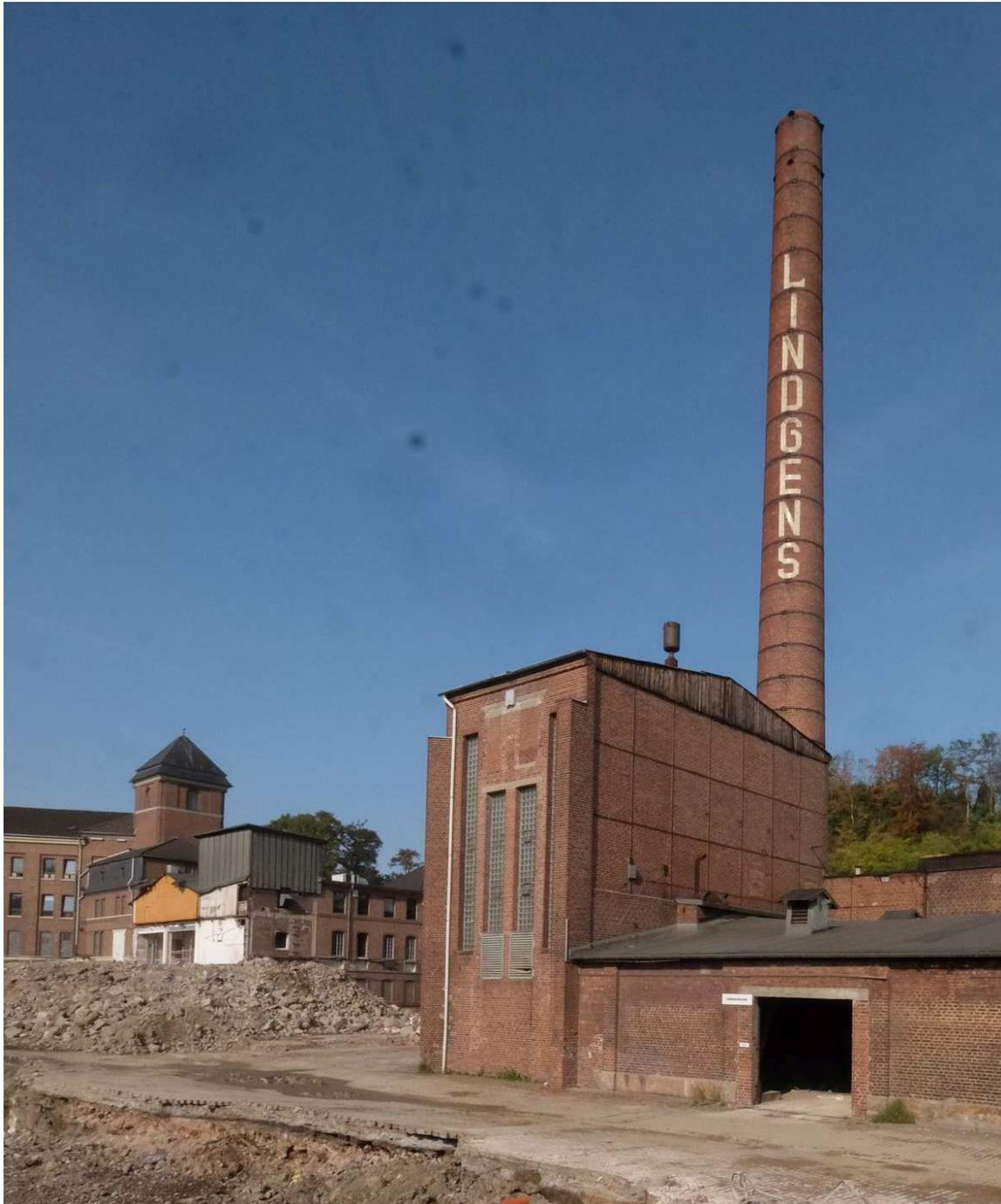
**Abb. 33: Kesselhaus (5), Blick auf die östliche Stirnwand mit Fensterbändern und den vermauerten Öffnungen der ehem. Kohlenbeschickung sowie auf die rückseitige, provisorische Giebelwand aus Stahlfachwerk mit Holzverschaltem Dachgiebel, dahinter (teilweise verdeckt) das Pumpenhaus (5a) und der Schornstein (5b), im Hintergrund das neue und das alte Fabrikgebäude. Foto: LVR-ADR, Rasmus Radach, 2019**
