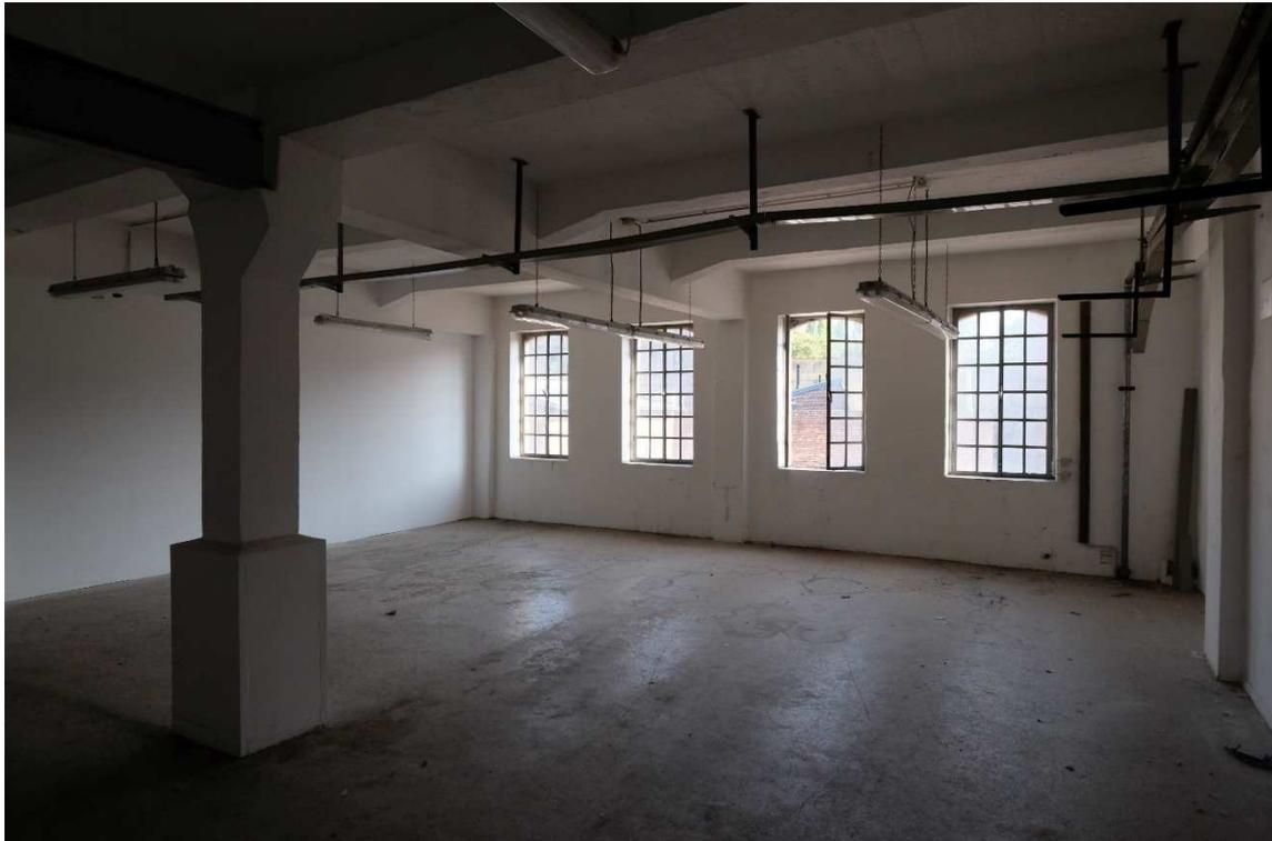
**Abb. 18: Altes Fabrikgebäude (1), Obergeschoss, hofseitige Erweiterung aus Eisenbeton von ca. 1922 mit Eisensprossenfenstern, Foto: LVR-ADR, Rasmus Radach, 2019**
