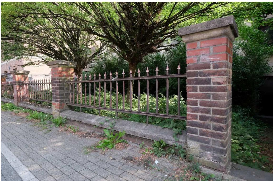
**Abb. 21: Neues Fabrikgebäude, straßenseitige Einfriedung mit gemauerten Pfosten und eisernen Zaunelementen (3b), Foto: LVR-ADR, Rasmus Radach, 2019**
