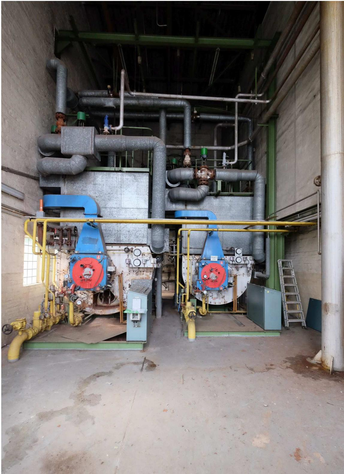
**Abb. 34: Kesselhaus (5) von 1940, Kesselraum im Obergeschoss mit zwei gasbefeuerten Wanson-Kesseln (Bj. 1978) zur Dampferzeugung, Foto: LVR-ADR, Rasmus Radach, 2019**
