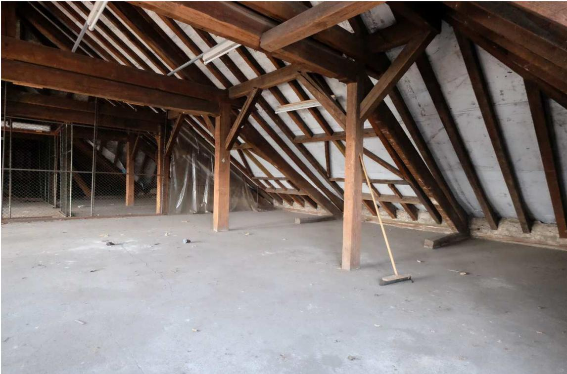
**Abb. 29: Verwaltungsgebäude (4), nicht ausgebautes Dachgeschoss mit nachträglich verschlossenen Dreiecksgauben, Foto: LVR-ADR, Rasmus Radach, 2019**
