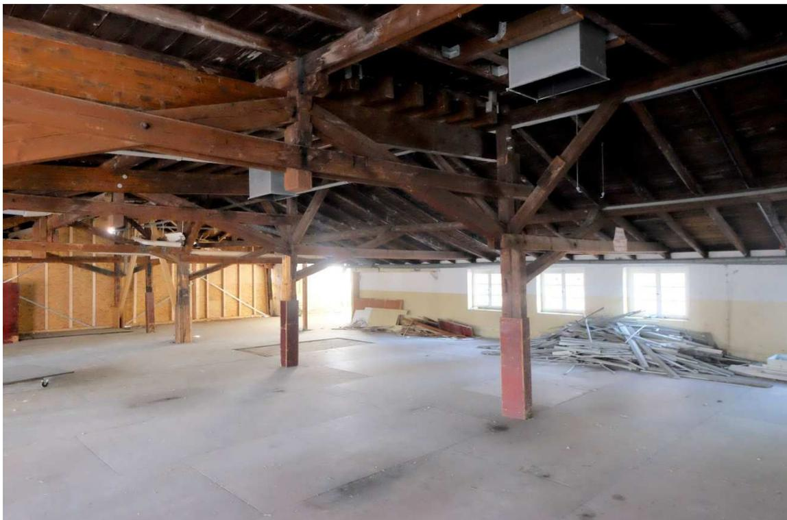
**Abb. 17: Altes Fabrikgebäude (1), Dachstuhl mit Mittelstützen, hofseitiger Erweiterung (links) und provisorisch gesicherter Abbruchkante (hinten), Foto: LVR-ADR, Rasmus Radach, 2019**
