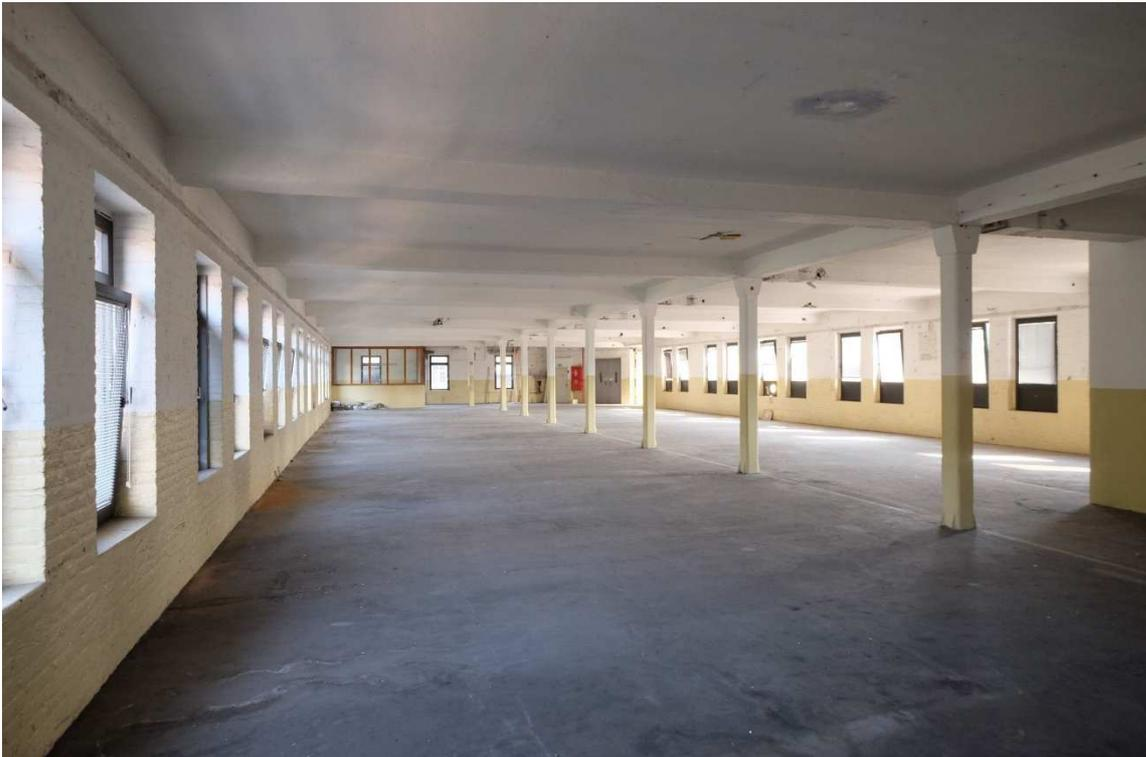
**Abb. 24: Neues Fabrikgebäude (3), 2. Obergeschoss, Großraum mit Eisenbetondecke auf Mittelstützen, Blick zum Aufzug, Foto: LVR-ADR, Rasmus Radach, 2019**
