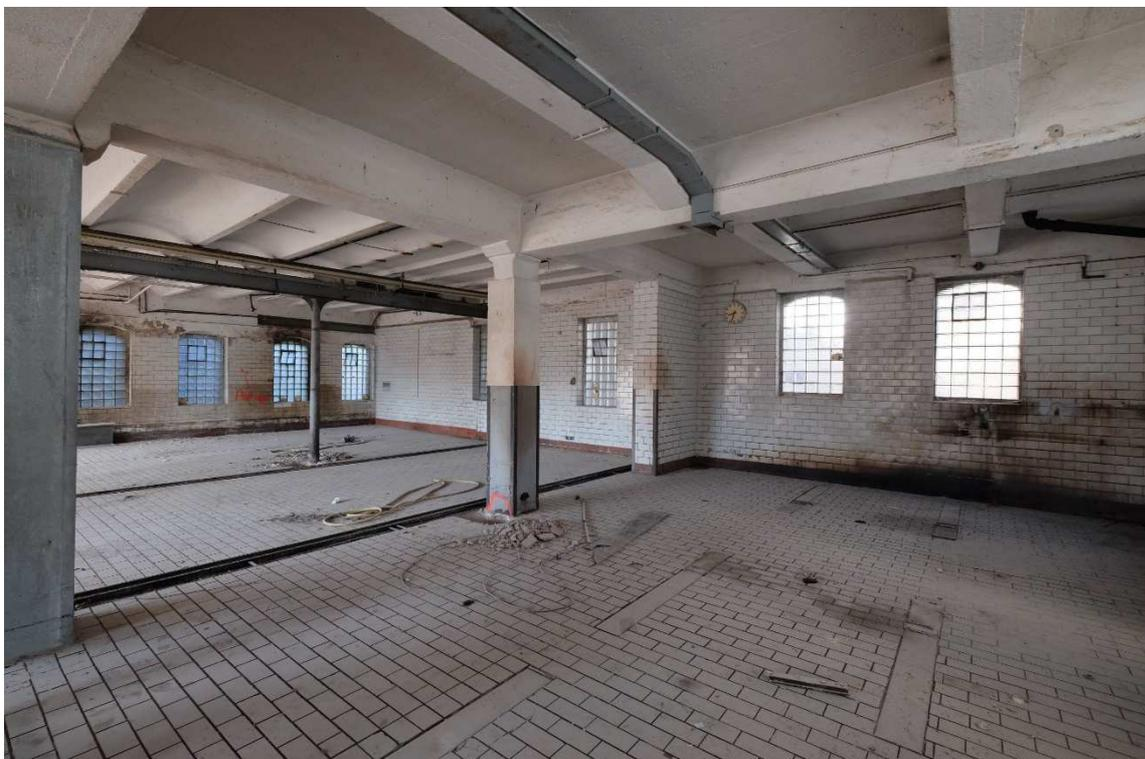
**Abb. 19: Altes Fabrikgebäude (1), Erdgeschoss, Eisenkonstruktion von 1884 (hinten) mit Erweiterung aus Eisenbeton von ca. 1922 (vorne), Foto: LVR-ADR, Rasmus Radach, 2019**
