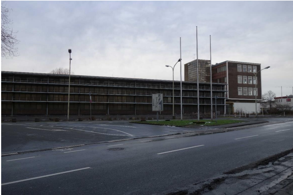
Mülheim an der Ruhr, Wiesenstraße 36, Ausbildungszentrum Phoenix Rheinrohr AG, Werkstatthalle (links im Bild), Foto: NF, LVR-ADR, 2021.
