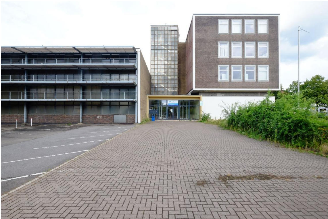
Mülheim an der Ruhr, Wiesenstraße 36, Ausbildungszentrum Phoenix Rheinrohr AG, Südansicht mit Verwaltungs- und Schulungsgebäude (rechts), Treppenturm (mittig) und Lehrwerkstatt (links), Foto: Rasmus Radach, LVR-ADR, 2019.
