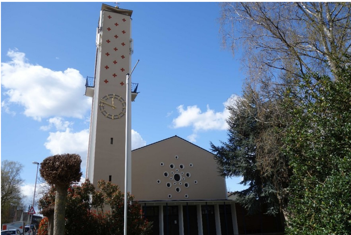
Mülheim an der Ruhr, Kleiststraße 93, St. Theresia vom Kinde Jesu, Ostansicht, Foto: Nadja Fröhlich (NF), LVR-ADR, 2021.
