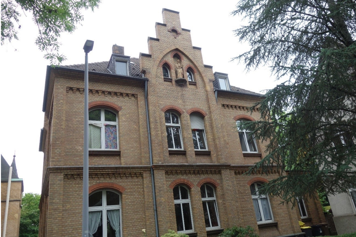
Mülheim an der Ruhr, Marienplatz 9, Südwestfassade des Pfarrhauses, Foto: NF, LVR-ADR, 2022.
