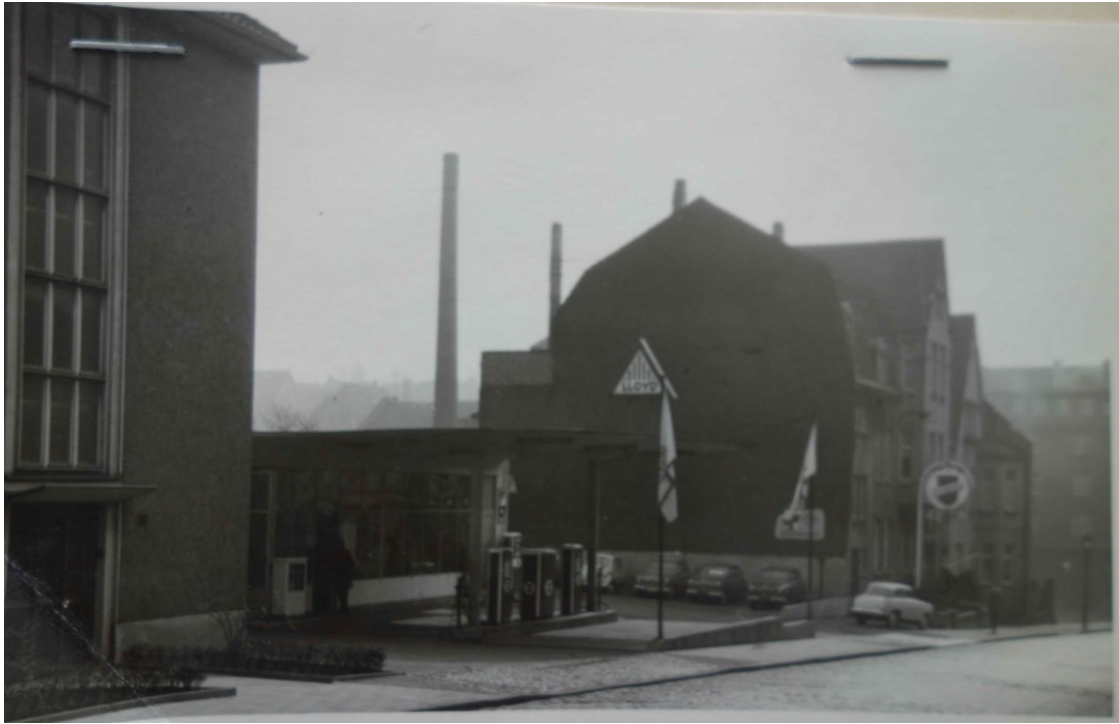
Bauzeitliches Foto der Tankstelle, Bauakte der Stadt Mülheim an der Ruhr.
