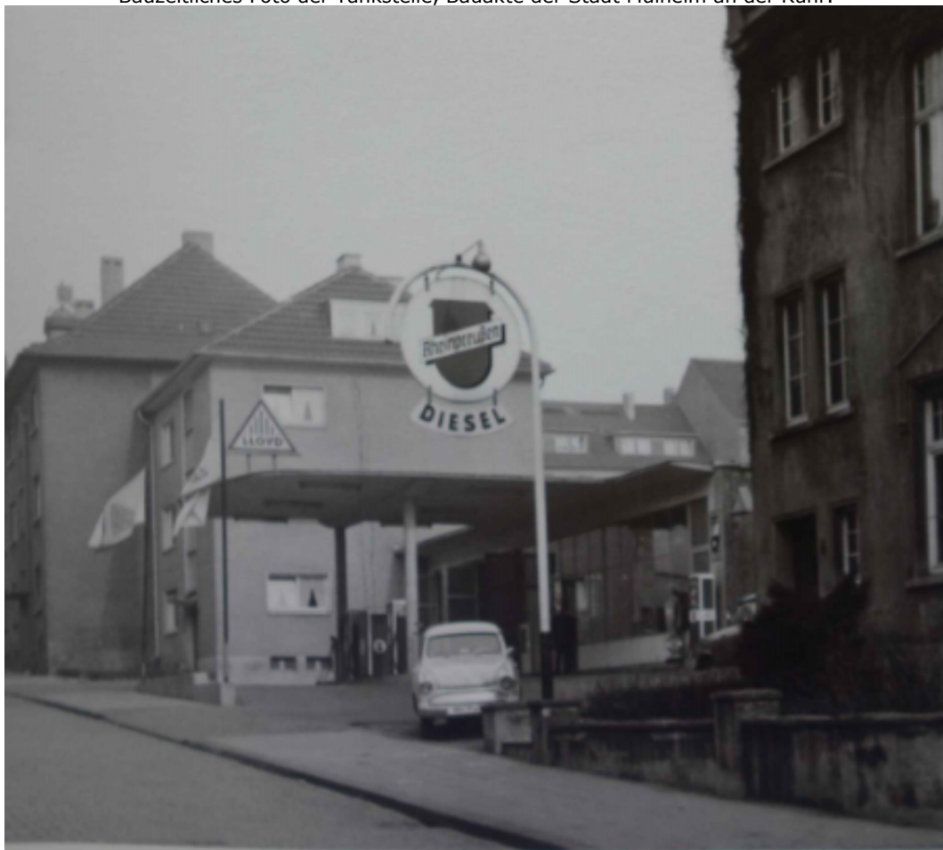
Bauzeitliches Foto der Tankstelle, Bauakte der Stadt Mülheim an der Ruhr.
