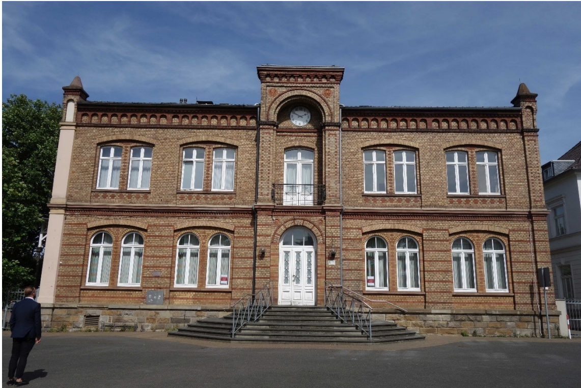
Mülheim an der Ruhr, Hingbergstraße 375, ehem. Rathaus Heißen, Südostansicht, Foto: Nadja Fröhlich (NF), LVR-ADR, 2022.
