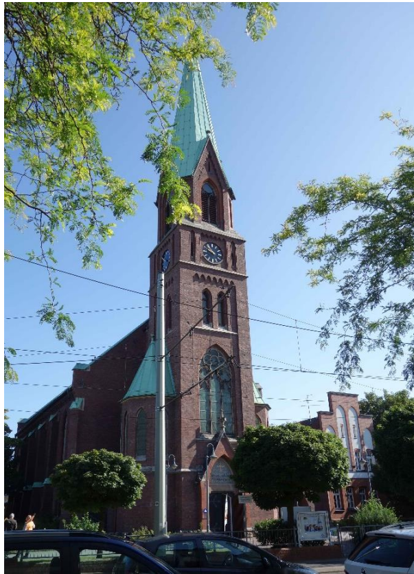
Mülheim an der Ruhr, ev. Lutherkirche, Südseite, Foto: Nadja Fröhlich (NF), LVR-ADR 2023.
