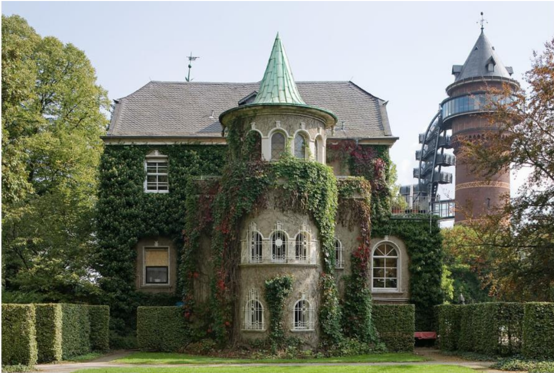
Mülheim an der Ruhr, Moritzstraße 102, Schloss Styrum, Westfassade, Foto: Viola Blumrich, LVR-ADR, 2009.
