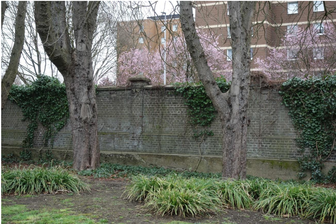
Mülheim an der Ruhr, Moritzstraße 102, Einfriedung (Abschnitt im Norden entlang der Moritzstraße, Ansicht vom Garten aus), Foto: NF, LVR-ADR, 2022.
