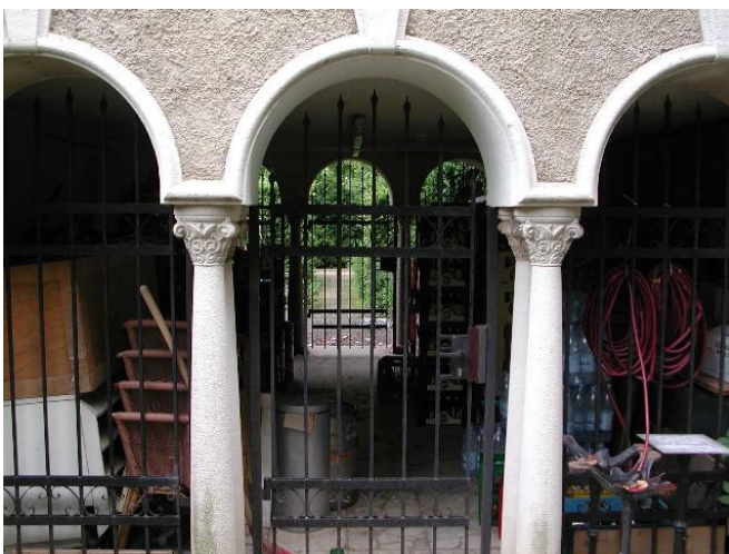
Mülheim an der Ruhr, Moritzstraße 102, Schloss Styrum, Südseite, Detail der Arkaden, Foto: Sigrun Heinen, LVR-ADR, 2008.
