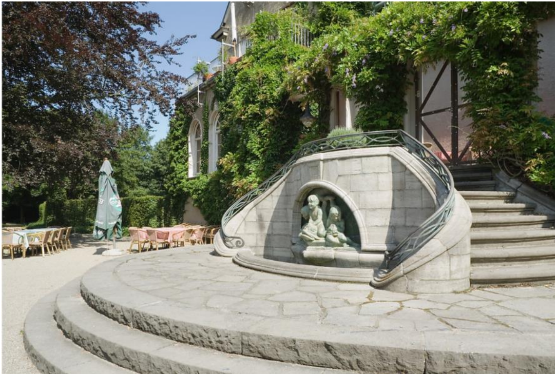
Mülheim an der Ruhr, Moritzstraße 102, Schloss Styrum, Westfassade, Foto: Viola Blumrich, LVR-ADR, 2009.
