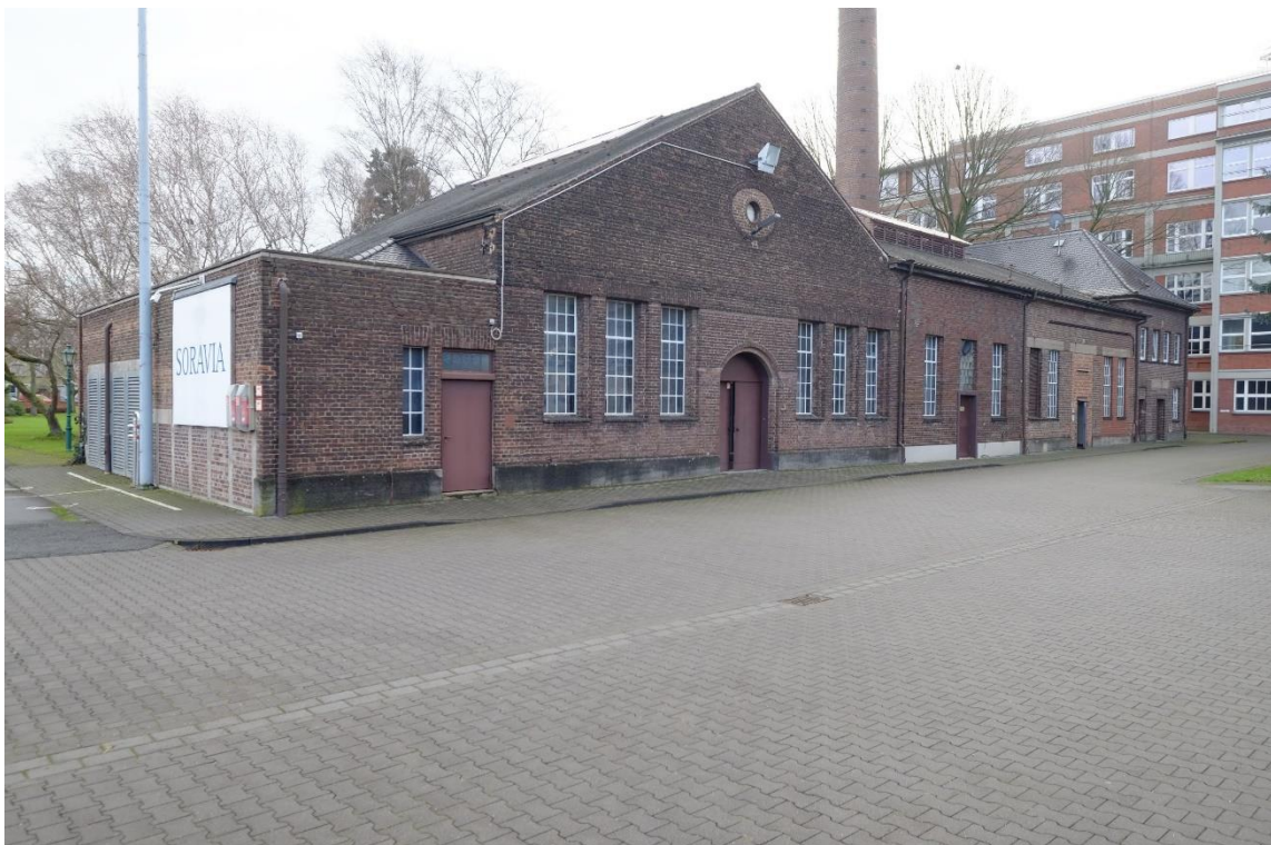
Mülheim an der Ruhr, Wissollstraße 10/Ulmenallee, Kraftzentrale des ehem. städtischen Schlachthofes, Westansicht, Foto: Rasmus Radach, LVR-ADR, 2021.
