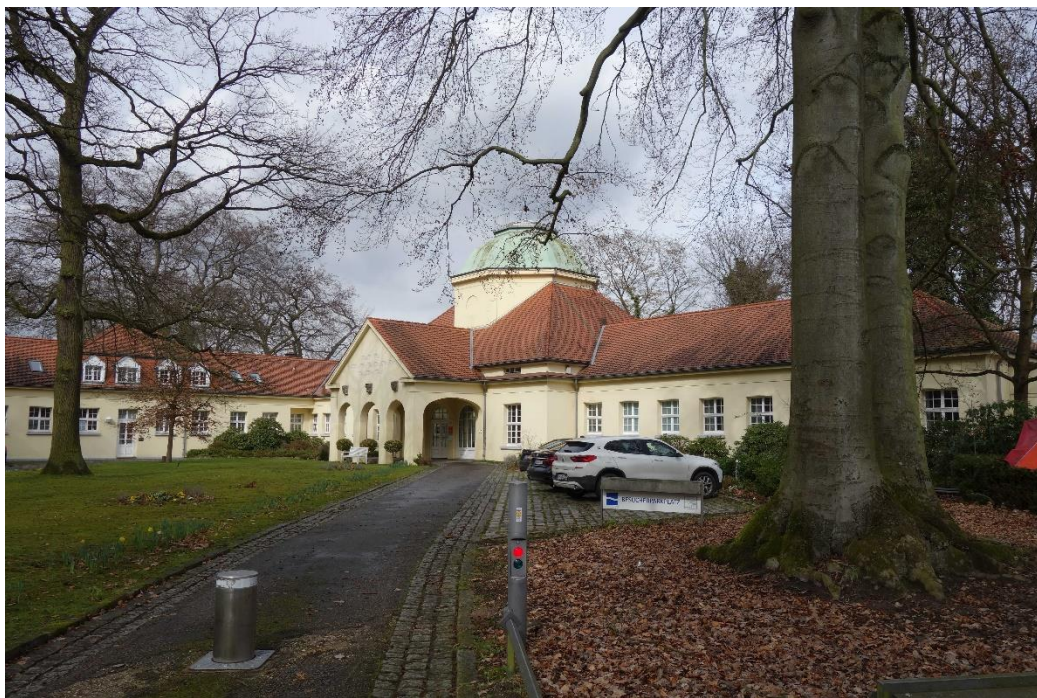
Mülheim an der Ruhr, Solbad Raffelberg, Südansicht des ehem. Badehauses, Foto: Nadja Fröhlich (NF), LVR-ADR, 2021.
