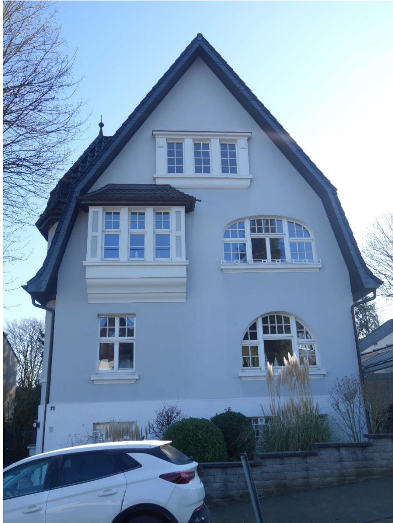
Abb. 1: Westseite mit bauzeitlicher Einfriedung, Foto: Nadja Fröhlich (NF), LVR-ADR, 2025.
