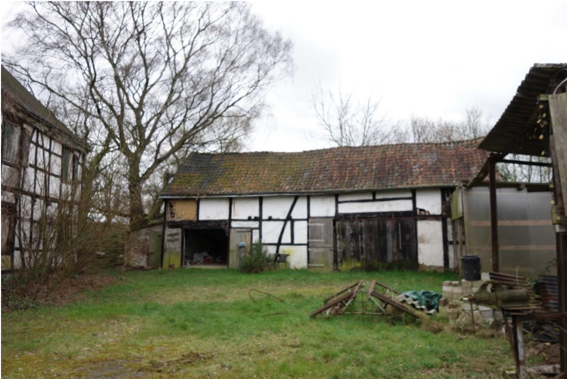
Freistehende Scheune im Süden, nördliche Traufseite, Foto: NF, LVR-ADR 2023.
