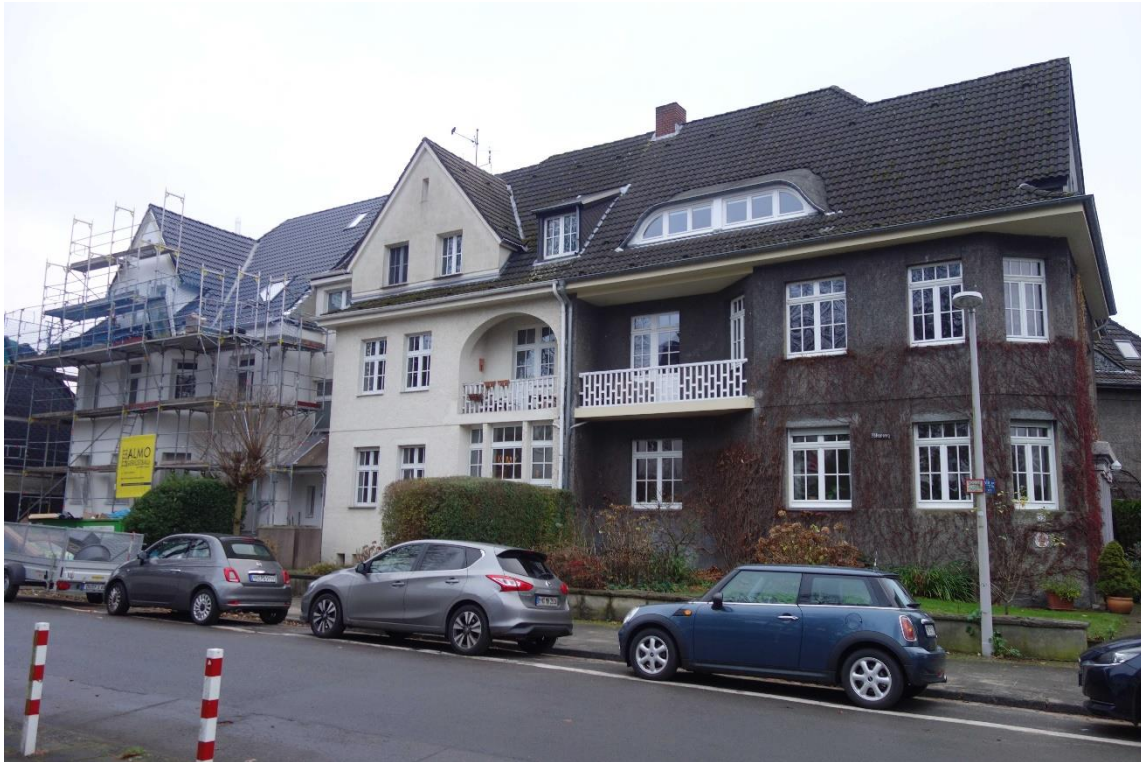
Abb. 3: Straßenseitige Ansicht der Hausgruppe Höhenweg 31-35, Foto: Nadja Fröhlich, LVR-ADR, 2024.
