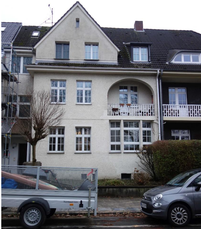
Abb. 2: Straßenseitige Fassade, Foto: Nadja Fröhlich, LVR-ADR, 2024.
