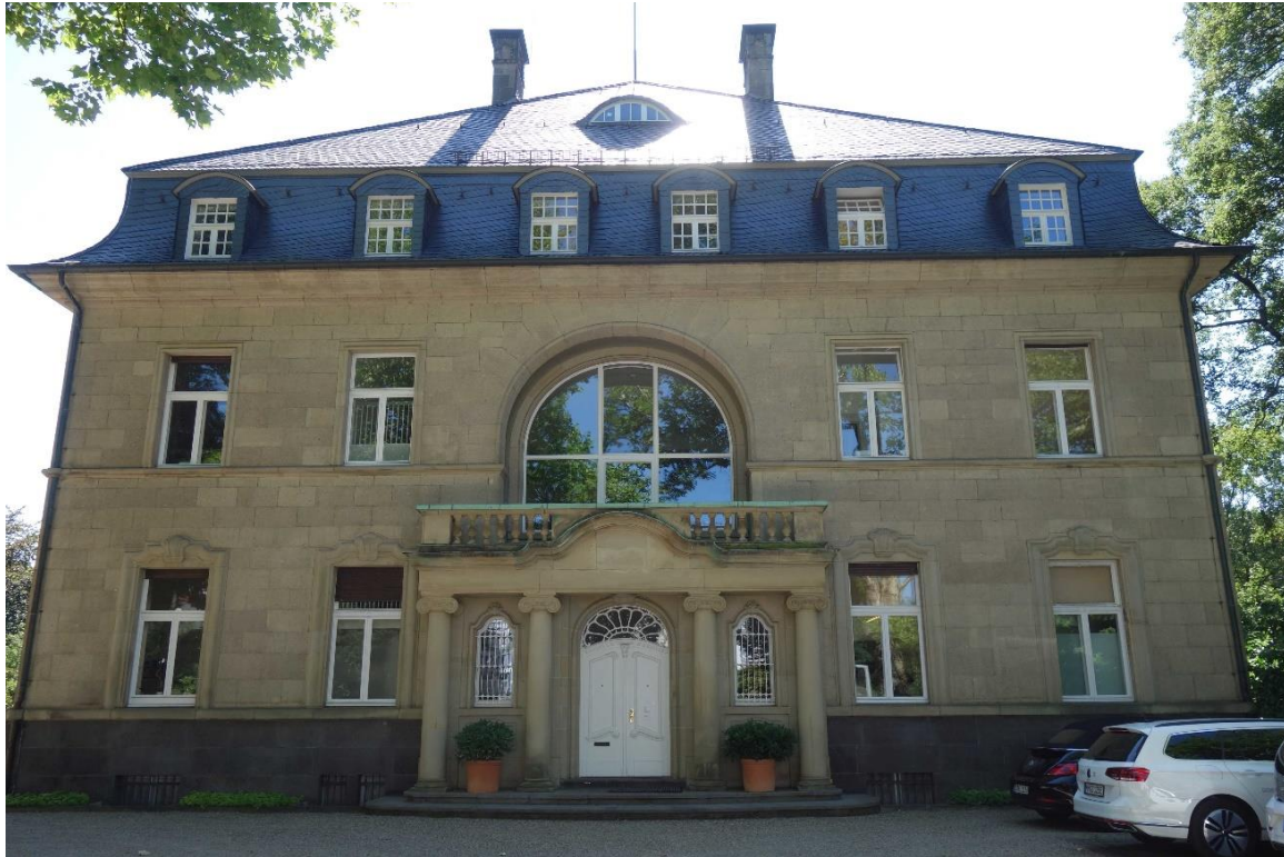
Mülheim an der Ruhr, Bismarckstraße 28, Haus Urge, Nordseite, Foto: Nadja Fröhlich (NF), LVR-ADR, 2022.
