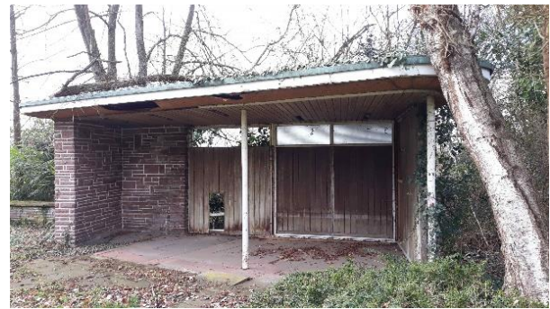
Pavillon, teils aus rotem Werksteinmauerwerk errichtet, teils in Leichtbauweise als weiß lackierte Holzkonstruktion, nach Osten hin offen, vorkragendes Flachdach mit abgerundetem Rand, zwei schlanke, weiß lackierte Stützpfiler
