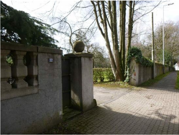
Nebenzufahrt zum ehem. Kutscherhaus (Bismarckstraße 32), Pfeiler aus verputztem Ziegelmauerwerk mit Abdeckung aus Naturstein und aufgesetzter Kugel, separater Zugang mit Tür, Toranlage fehlt, abschnittsweise blickdurchlässige Baluster-Einfriedung aus Kunststein auf halbhochem verputztem Mauersockel
