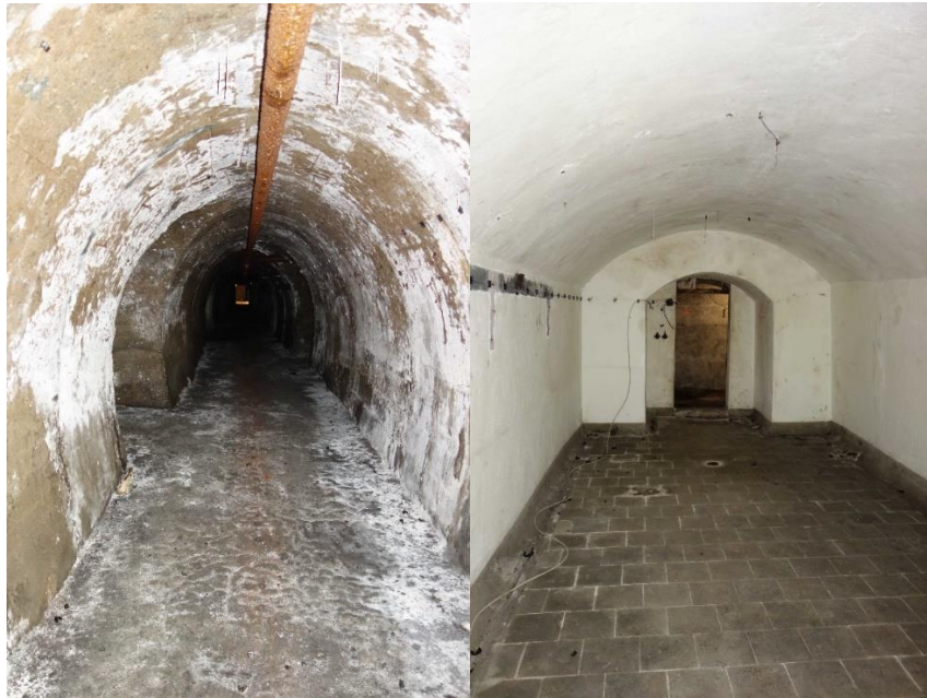
Mülheim, Bismarckstraße 28, Innenaufnahmen des Luftschutzstollens, links: westlicher Bereich, rechts: östlicher Bereich mit verputzten Wänden und Plattenbelag, Fotos: NF, LVR-ADR, 2022.
