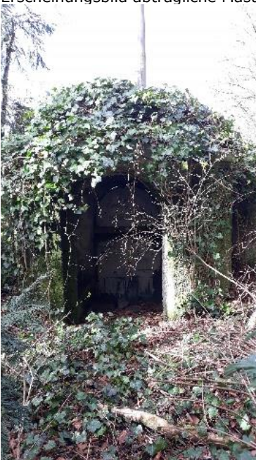
Blick aus dem Villengarten in den Eckpavillon aus verputztem Ziegelmauerwerk mit Kuppel
