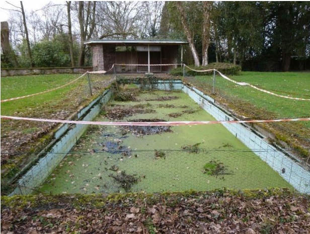
Wasserbecken, rechteckig, bodenbündig eingebaut, Mauerabdeckung aus Natursteinplatten (roter Sandstein), im sanierungsbedürftigen Zustand (provisorisch gesperrt)
