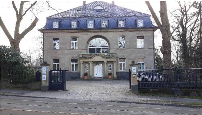
Hauptzufahrt an der Bismarckstraße, ausgerichtet auf das Portal des Haupthauses, Pfeiler aus Naturstein mit aufgesetzter profilierter Abdeckung und bekrönender Kugel, Toranlage (erneuert)
