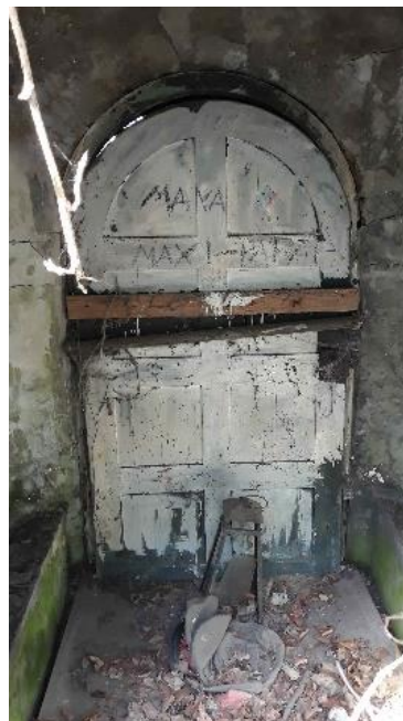
Innere des Eckpavillons mit wandfesten Sitzbänken und Holztür (von außen zugesetzt, Bodenbelag nicht erkennbar)
