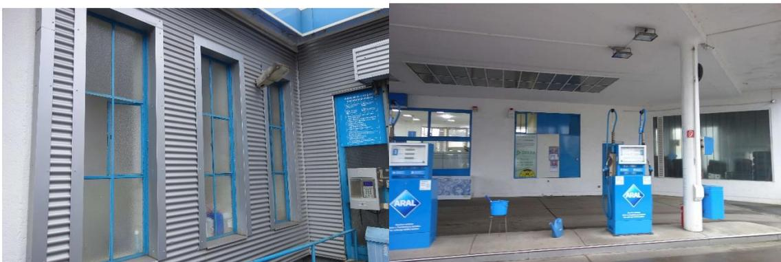
Links: Stahlrahmenfenster im Bereich der Wagenwaschhalle, rechts: Zapfsäuleninsel mit Rundstütze, Vordach und veränderter Eingangsfront auf der Nordseite, Fotos: NF, LVR-ADR, 2023.
