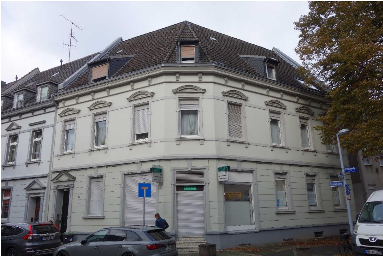
Mülheim an der Ruhr, Wielandstraße 25, straßenseitige Ansicht, Foto: Nadja Fröhlich, LVR-ADR 2021.
