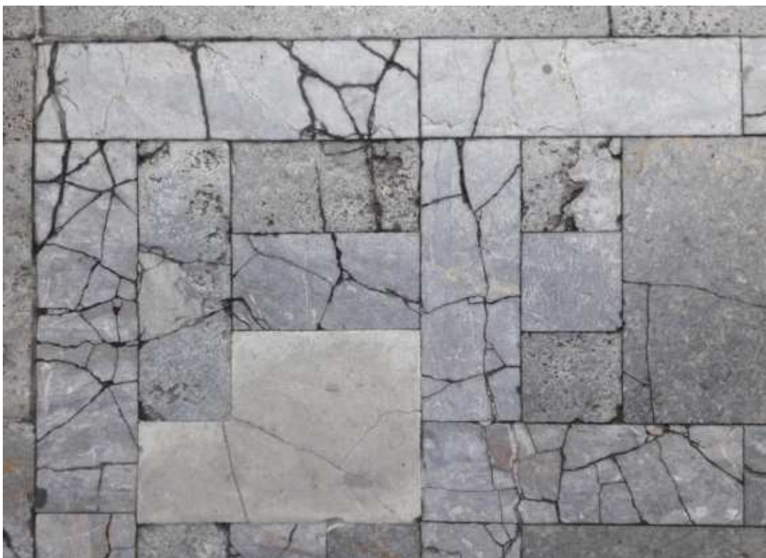
Abb. 4: Helle neu ausgetauschte Steinplatte die bereits gebrochen ist. Die farbigen Kalksteinplatten sind ebenfalls in zahlreiche Bruchstücke zerbrochen. Foto Schrimpf.
