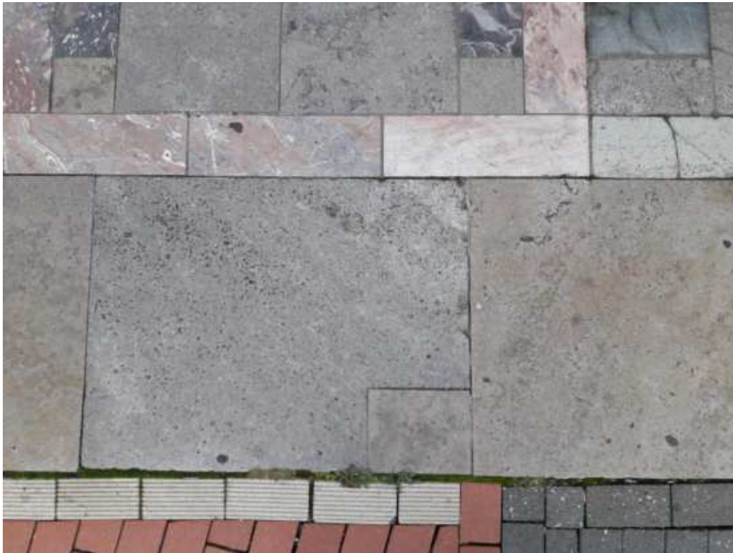
Abb. 5: Vierung in einer Muschelkalkplatte. Foto Schrimpf.
