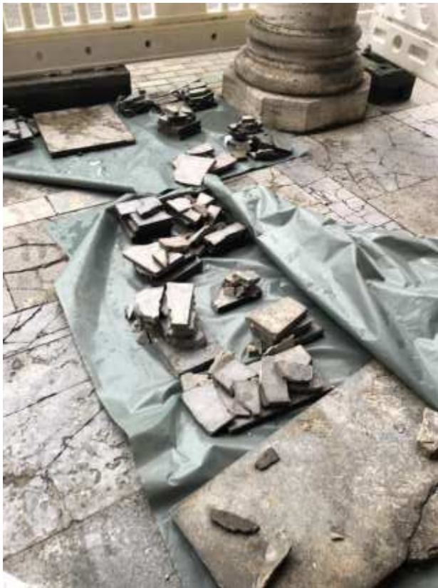
Abb.7: Nach Abnahme eines kleinen Bereichs der Bodenplatten. Foto: König.
