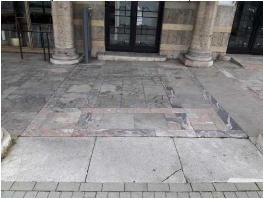
Abb. 6: Unterschiedliche Schadensbilder wie zerbrochene Platten, mit Mörtel ergänzte Platten und ausgetauschte Platten.
