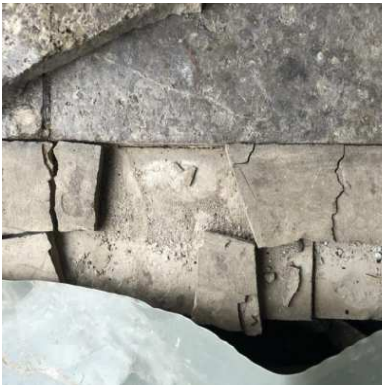
Abb. 8: Aufbau der Konstruktion der Bodenplatten. Foto: König.
