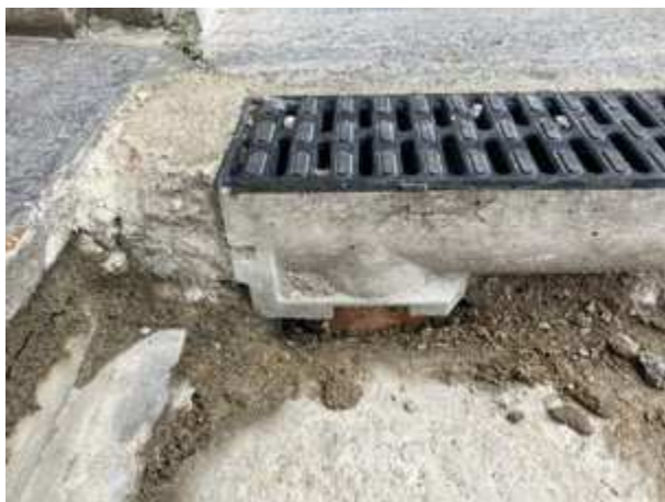
Bodenrinne ohne funktionierende Abdichtungseben
