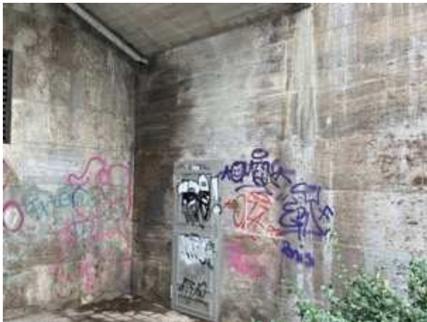
Starke Durchfeuchtung im Bereich des Bauteilanschlusses
