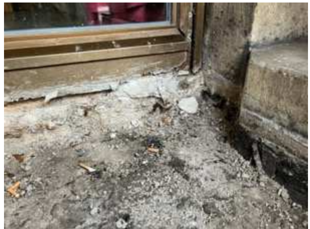
Bauteilöffnung: Defekte Schwelle der Stahl-Glas-Fassade ohne Abdichtung
