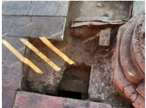
Bauteilöffnung: Übergang Arkadengang / Freitreppe
