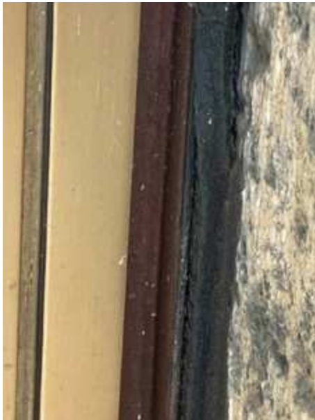
Seitlicher Anschluss mit defekter Dichtung
