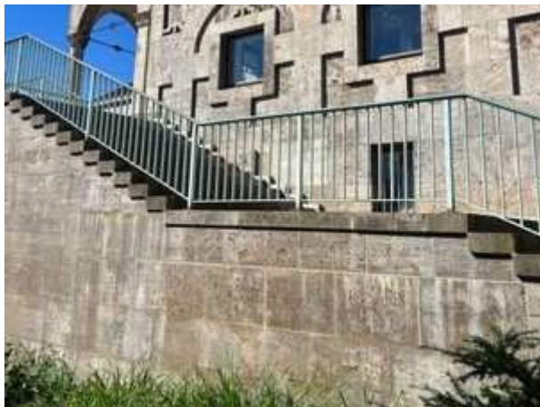
Starke Verfärbungen und Wasserläufer am Fugennetz
