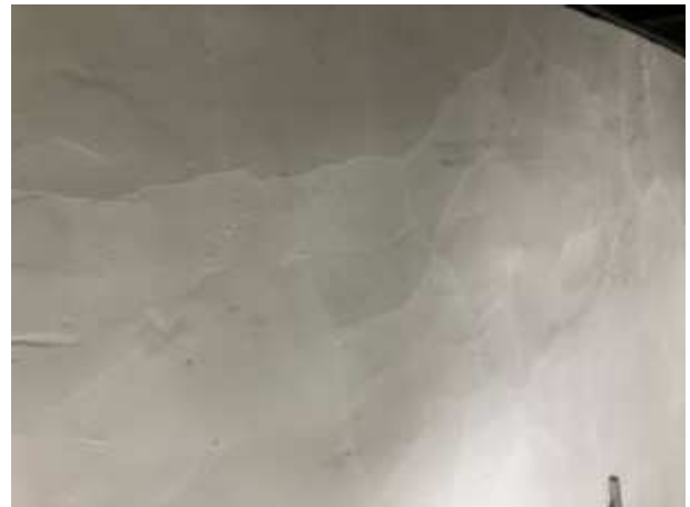
Stark gerissener Innenputz an der Außenwandinnenseite
