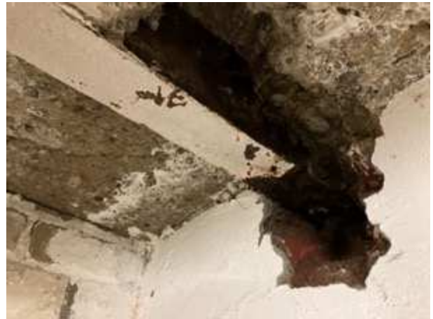
Bauteilöffnung: Freigelegter Stahlträger I180, Wandaufleger
