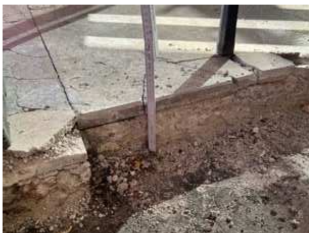
Bauteilöffnung: Aufbauhöhe Bodenbelag
