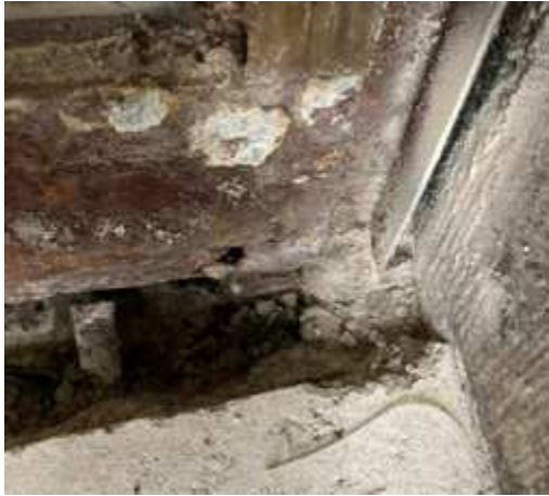
Unterkonstruktion, korrodierter Stahl
