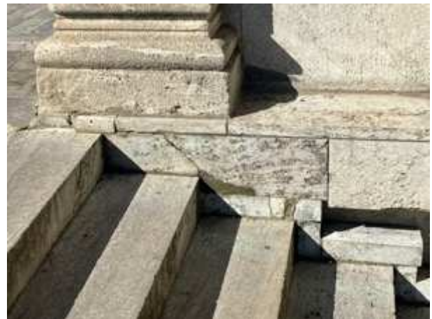
Sichtbare Schäden am Übergang Treppe zum Gebäude
