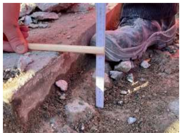
Bauteilöffnung: Aufbauhöhe Bodenbelag
