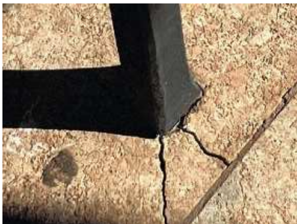
Rostsprengung an dem Brüstungsgeländer
