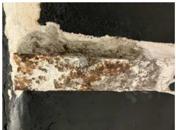
Bauteilöffnung: Freigelegter Stahlträger I180
