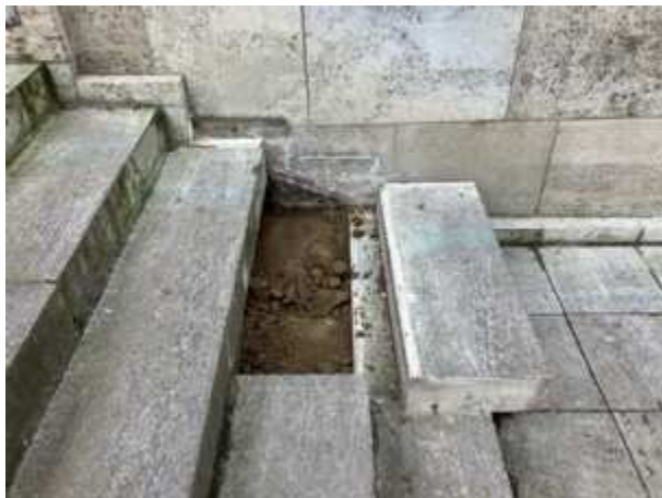
Ausgebaute Blockstufe
