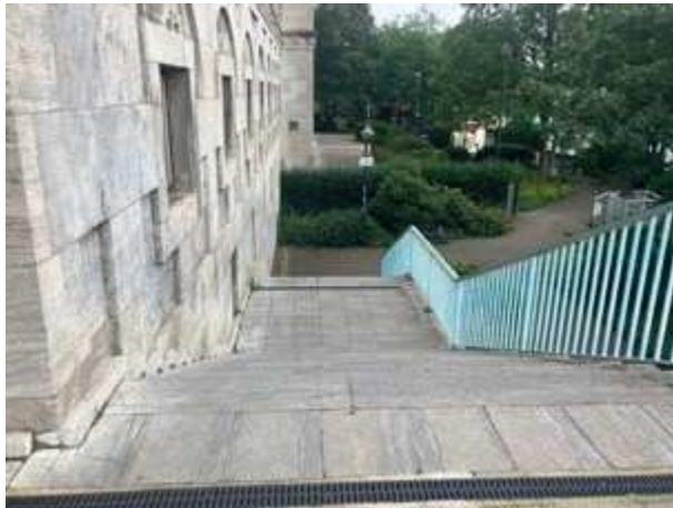
Gebrochene Platten sowie organischer Bewuchs
