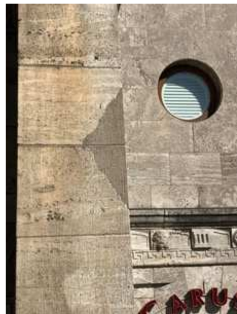
Antragung an der Pilasterecke
