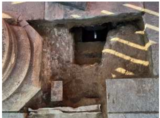
Bauteilöffnung: Übergang Arkadengang / Gehweg / Fußpunkt der Säule
