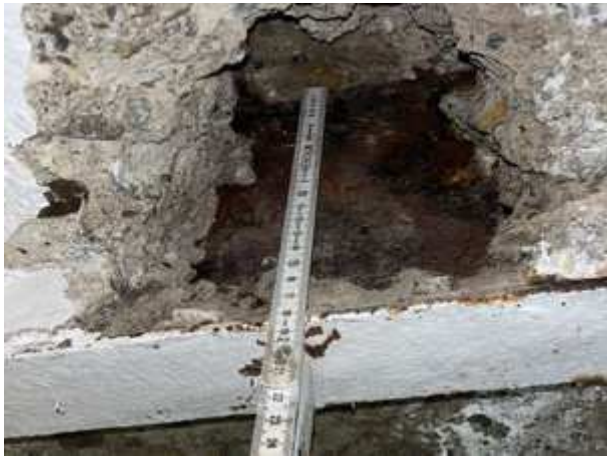
Bauteilöffnung: Freigelegter Stahlträger I180
