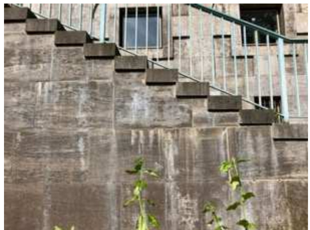
Außenfassade der Freitreppe: Ausblühungen und Steinverfärbungen deuten auf dauerhafte Bauteilfeuchte hin.
