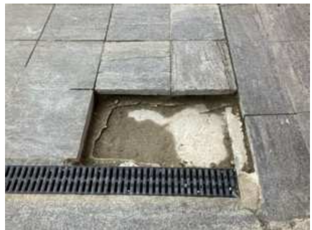
Abdichtungsebene aus Flüssigkunststoff
