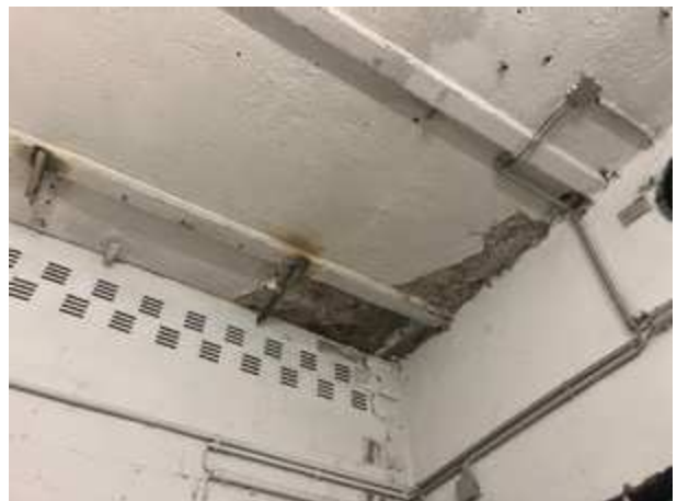
Massiver Feuchtigkeitseintrag im Untergeschoss
