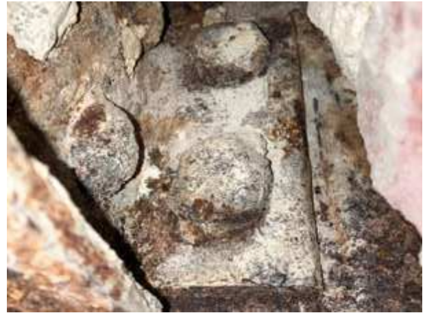
Bauteilöffnung: Verbindungsstück Neben- zu Hauptträger
