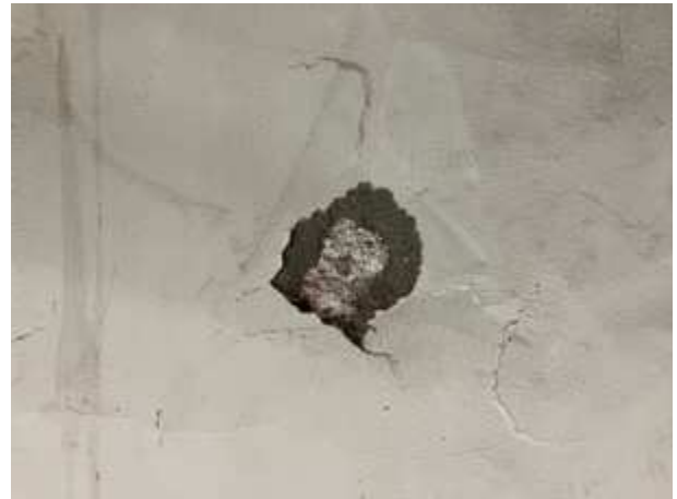
Putzabplatzung; starke Durchsalzung des Mauerwerks
