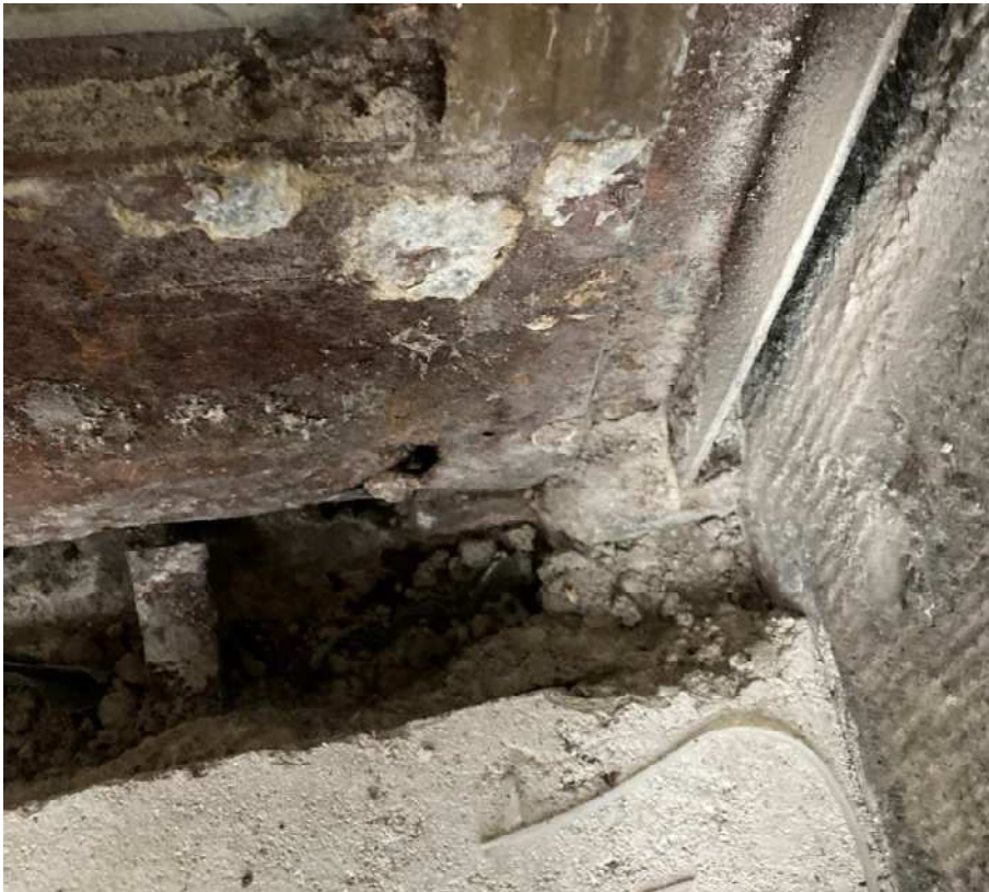
Bild 17: Bodenbefestigung rechte untere Ecke. Die Lasche ist durch den Korrosionsschaden nicht mehr mit dem Sockelprofil verbunden.
