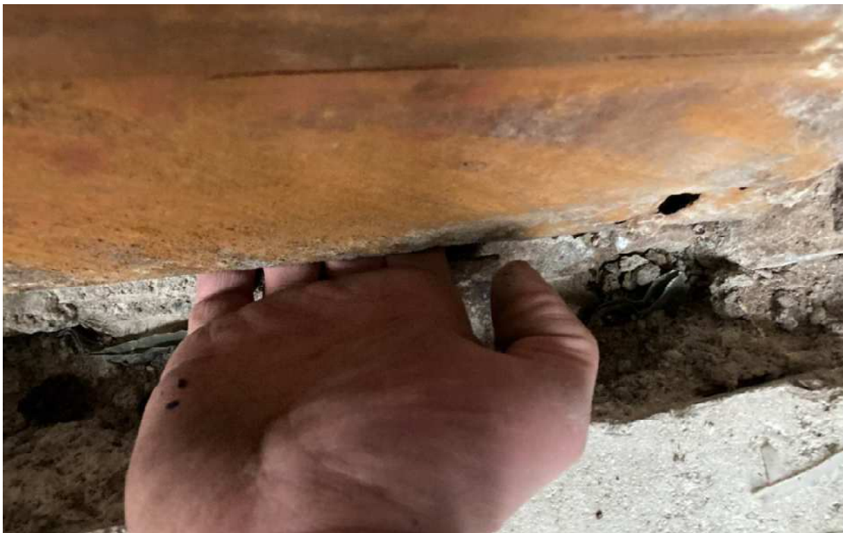
Bild 19: Kompletter Verlust des unteren Profilbereiches.
