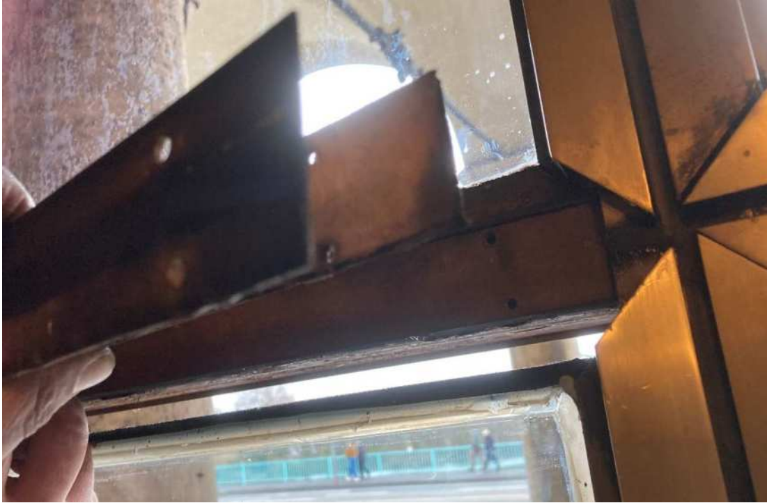
Bild 13: Aufbau der Anlage auf der Innenseite: Stahlprofil, Holzfaserstreifen und Alu-Blech.
