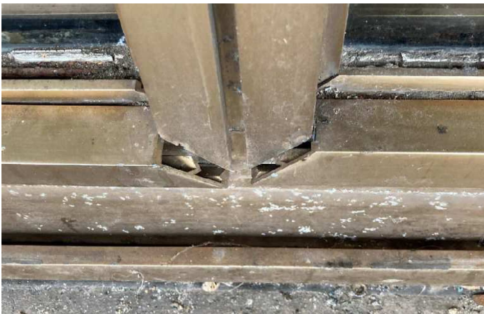
Bild 06: Schlecht sitzende, verbogene Abdeckleisten am Sockel der Fassade.
