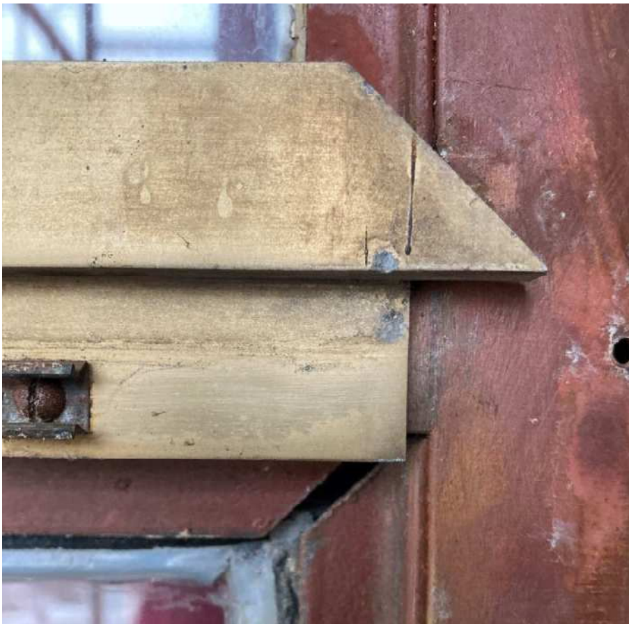
Bild 07: Oberfläche der Alu-Abdeckleiste und des darunter liegenden Alu-Blech.
