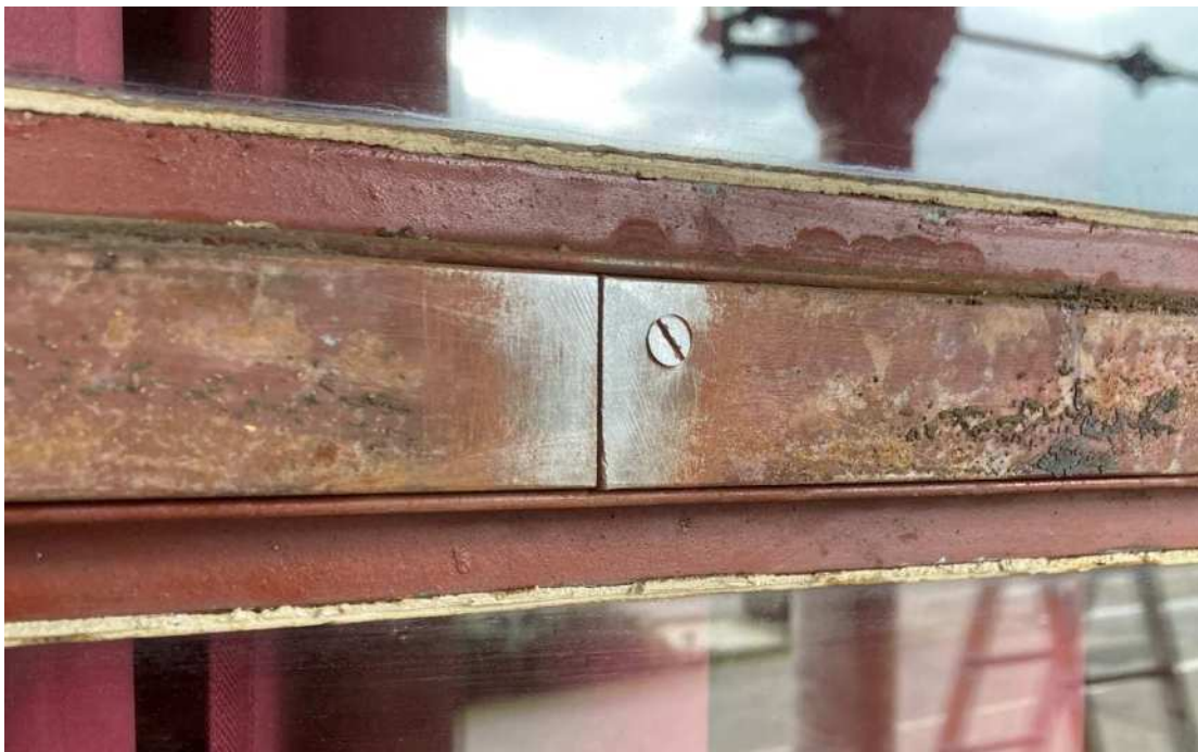
Bild 10: Horizontaler Koppelstoß am unteren Riegel zwischen Feld zwei und drei.
