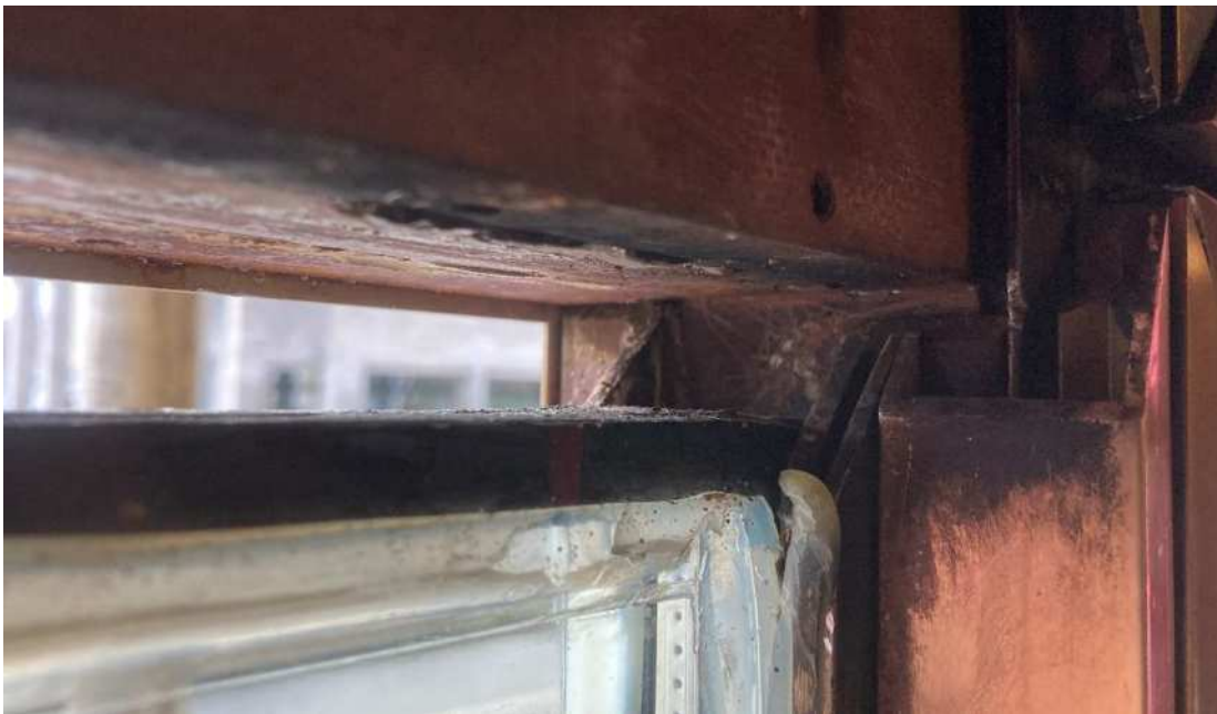
Bild 14: Blick von Innen nach Außen nach dem Entfernen der Glasleisten auf beiden Seiten.
