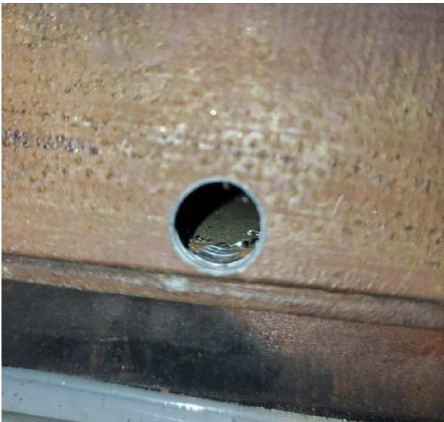
Bild 15: Pilotbohrung in Riegel oberhalb der Glasscheibe von außen gesehen unten rechts im rechten Feld der Anlage. Profillinenseiten kaum korrodiert.
