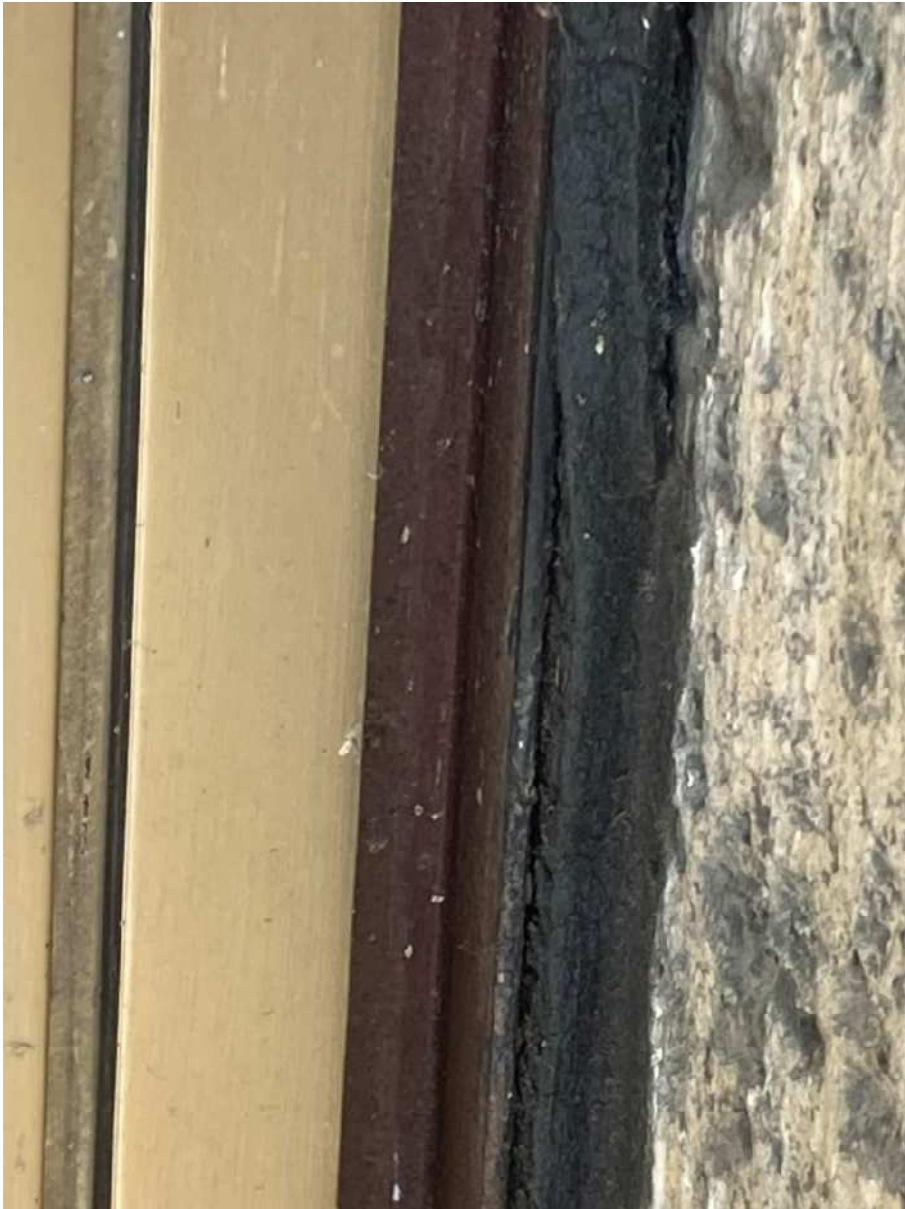
Bild 18: gerissene Bitumenabdichtung Wandanschluss rechts.
