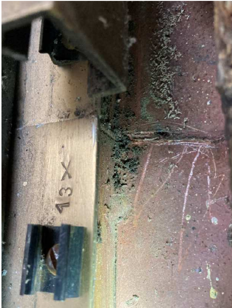
Bild 11: Koppelstoß in der Senkrechten.
