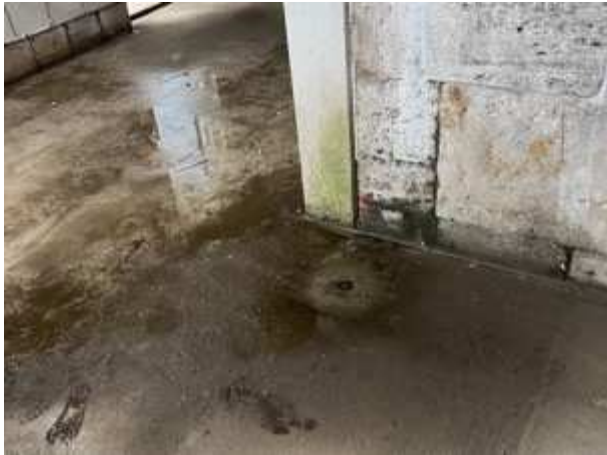
Starker Niederschlagseintrag unterhalb der Freitreppe
