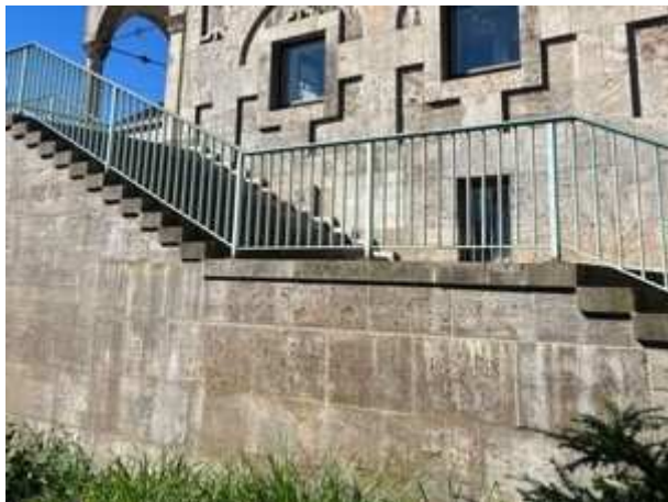
Starke Verfärbungen und Wasserläufer am Fugennetz
