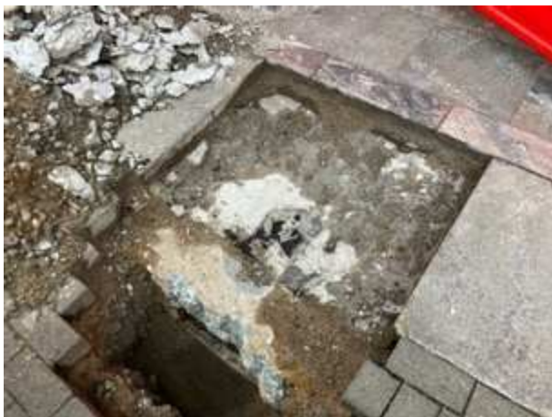
Bauteilöffnung: Übergang Arkadengang / Gehweg
