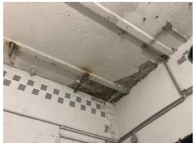
Massiver Feuchtigkeitseintrag im Untergeschoss
