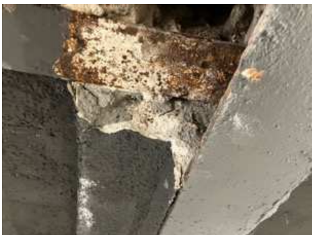
Bauteilöffnung: Freigelegter Stahlträger I180
