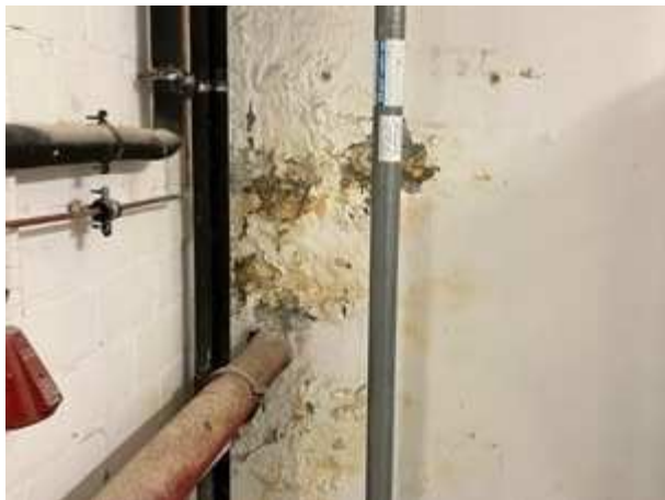
Starke Verfärbungen und Ausblühungen an der Trennwand
