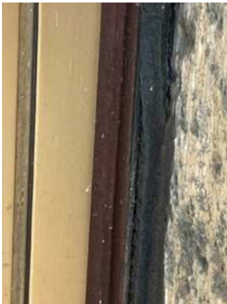
Seitlicher Anschluss mit defekter Dichtung
