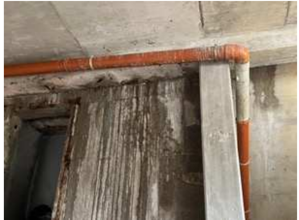
Sichtbar aktive Laufspuren von Niederschlag entlang der Bauteilfuge
