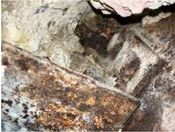
Bauteilöffnung: Freigelegter Stahlträger I180
