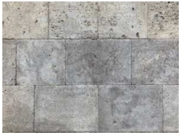
Teilweise defektes Fugennetz
