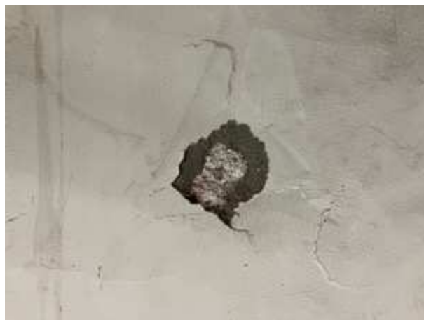
Putzabplatzung; starke Durchsalzung des Mauerwerks
