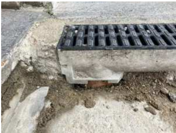
Bodenrinne ohne funktionierende Abdichtungseben
