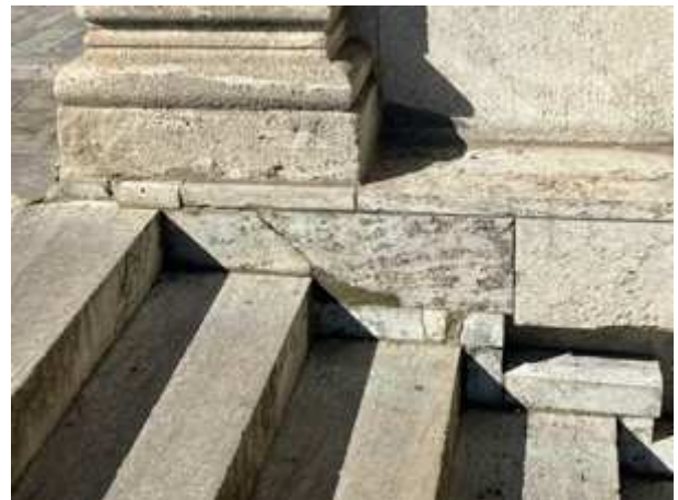
Sichtbare Schäden am Übergang Treppe zum Gebäude
