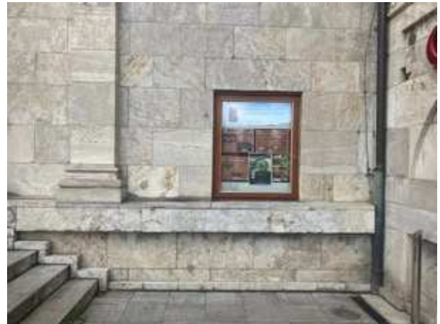
Gebrochene Platten sowie organischer Bewuchs
