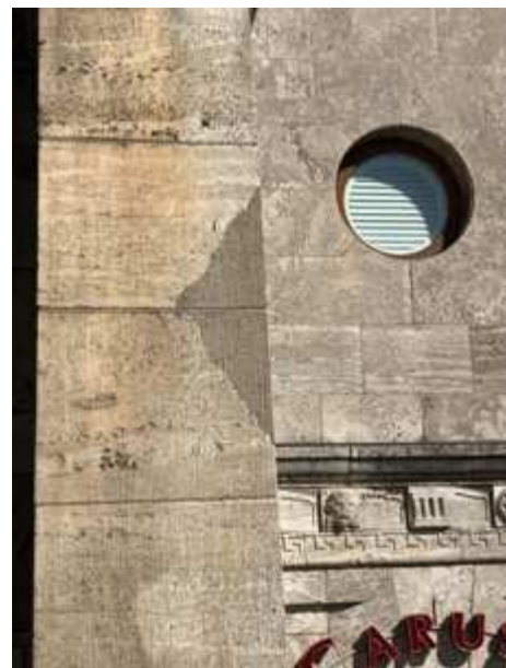
Antragung an der Pilasterecke
