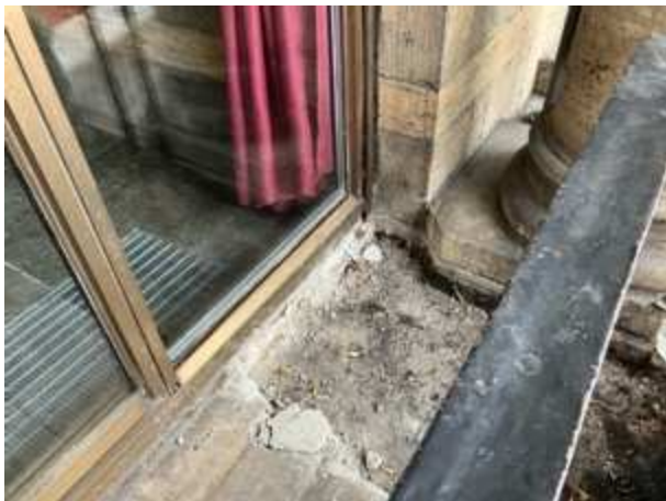
Bauteilöffnung: Defekte Schwelle der Stahl-Glas-Fassade ohne Abdichtung
