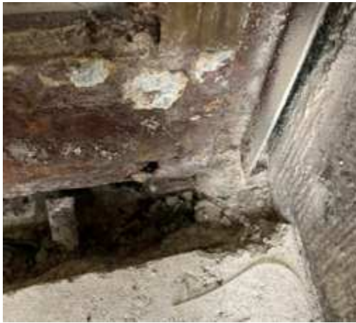
Unterkonstruktion, korrodierter Stahl
