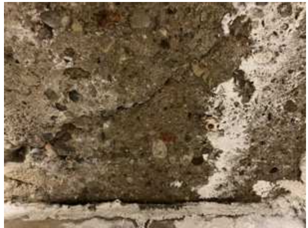
Deckenuntersicht: Detailaufnahme grobkörniger Beton mit starkem Rissbild.
