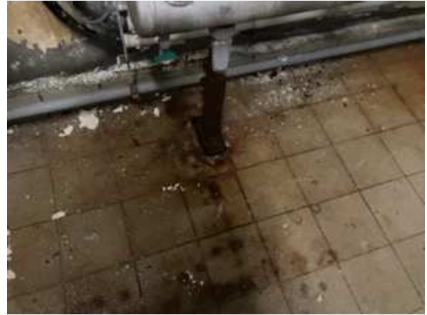
Massiver Feuchtigkeitseintrag im Untergeschoss
