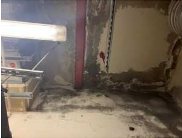
Massiver Feuchtigkeitseintrag im Untergeschoss
