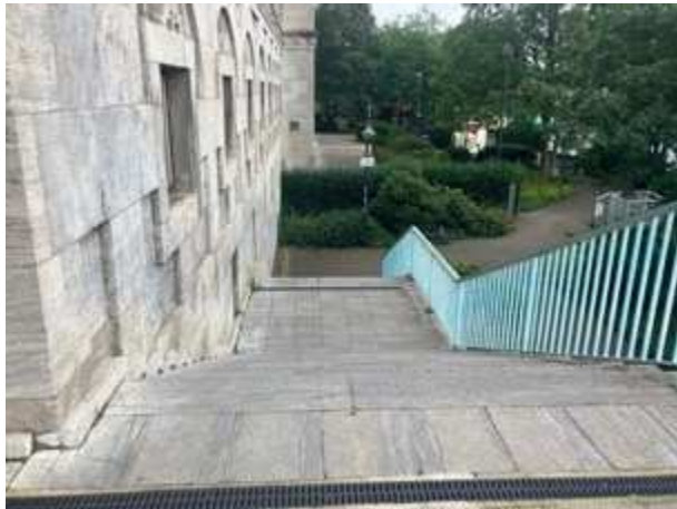
Gebrochene Platten sowie organischer Bewuchs
