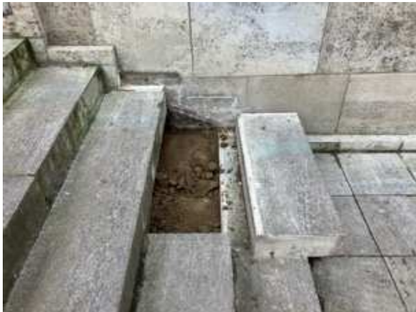
Ausgebaute Blockstufe
