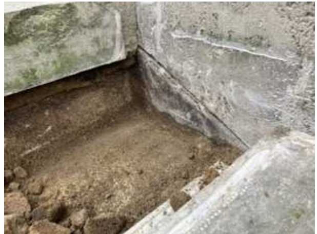
Abdichtungsebene aus Flüssigkunststoff, keine funktionierende Anbindung an die Außenfassade
