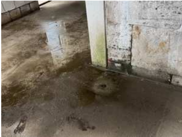
Starker Niederschlagseintrag unterhalb der Freitreppe
