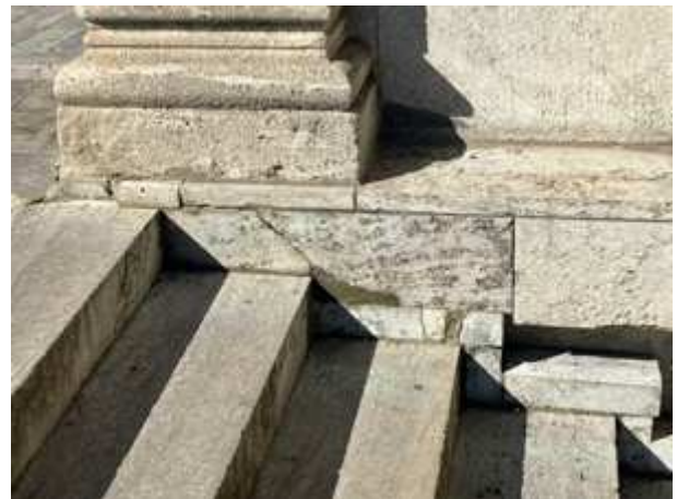
Sichtbare Schäden am Übergang Treppe zum Gebäude
