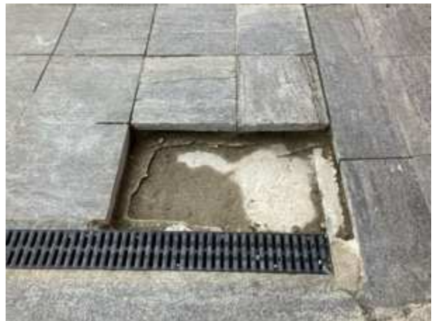
Abdichtungsebene aus Flüssigkunststoff
