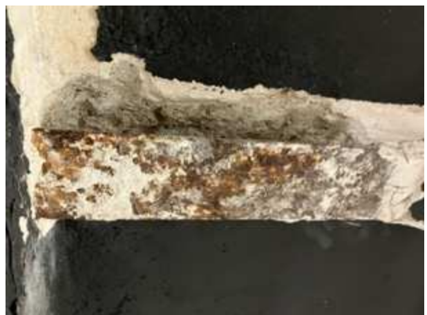
Bauteilöffnung: Freigelegter Stahlträger I180
