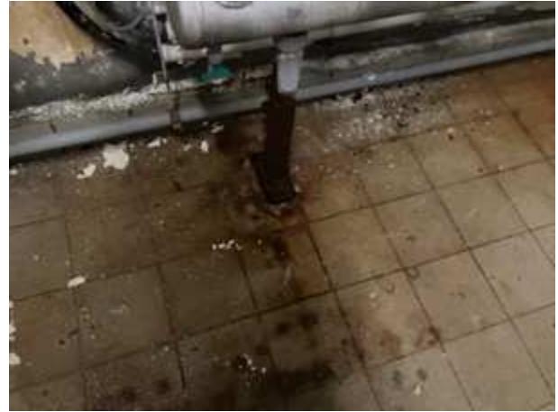
Massiver Feuchtigkeitseintrag im Untergeschoss
