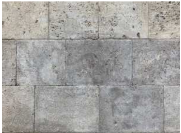
Teilweise defektes Fugennetz
