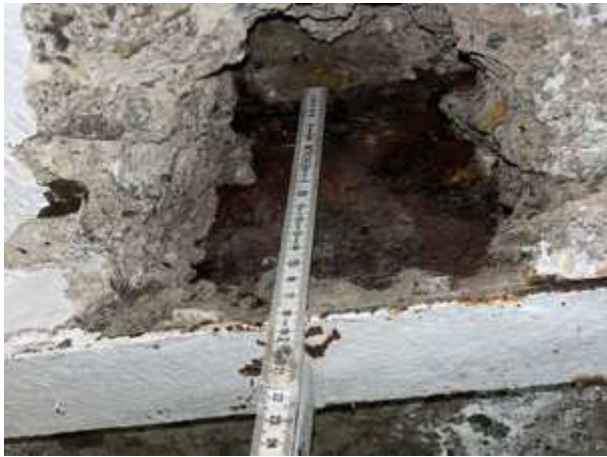
Bauteilöffnung: Freigelegter Stahlträger I180
