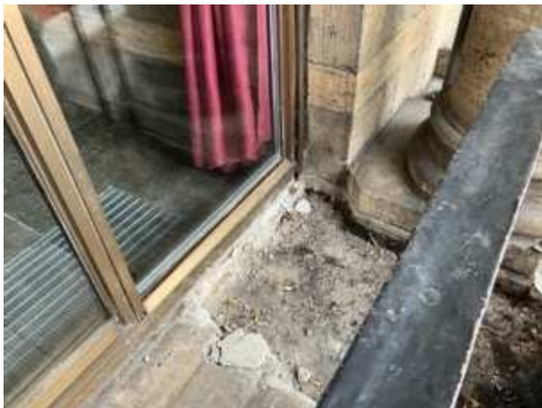
Bauteilöffnung: Defekte Schwelle der Stahl-Glas-Fassade ohne Abdichtung
