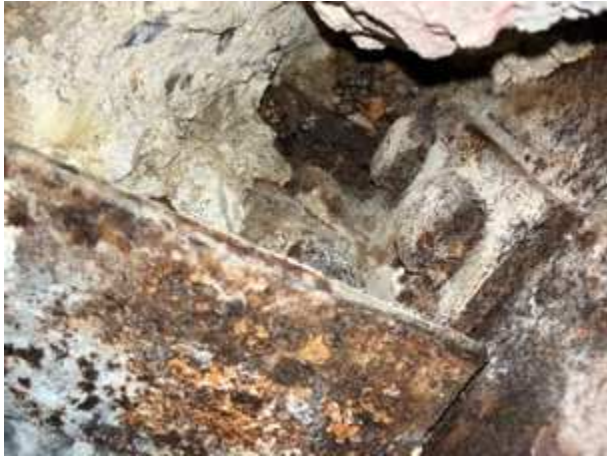
Bauteilöffnung: Freigelegter Stahlträger I180
