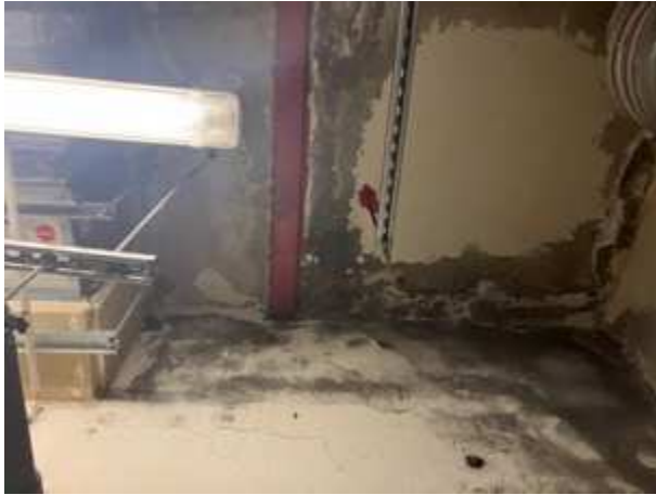
Massiver Feuchtigkeitseintrag im Untergeschoss
