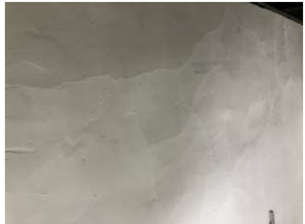
Stark gerissener Innenputz an der Außenwandinnenseite
