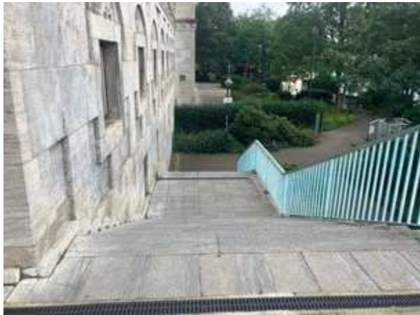
Gebrochene Platten sowie organischer Bewuchs
