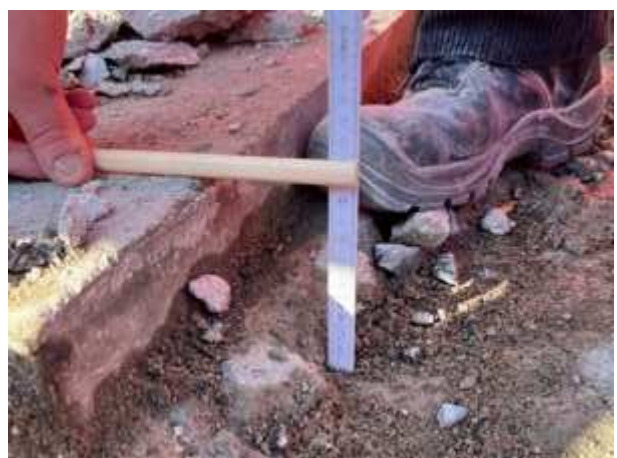
Bauteilöffnung: Aufbauhöhe Bodenbelag
