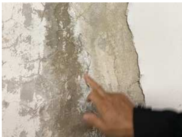
Außenwandinnenseite (Kellergeschoss) an der Freitreppenrückseite; die Druchfeuchtung und anschließende Salzausblühungen sind deutlich zu erkennen.
