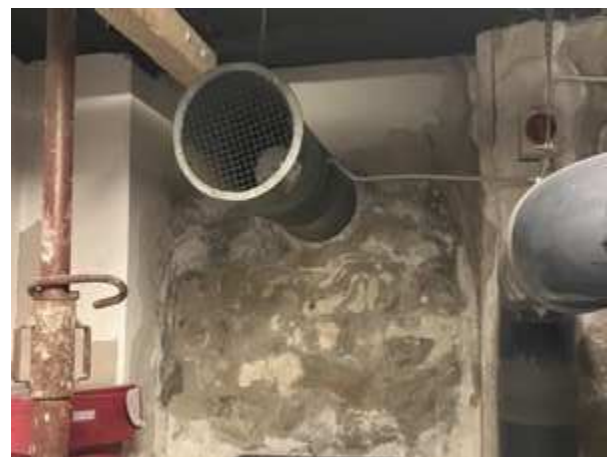
Außenwandinnenseite (Kellergeschoss) an der Freitreppenrückseite; der verzinkte Blechkragen der Rohrdurchführung ist durch die hohe Salzbelastung stark korrodiert.
