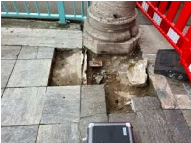
Bauteilöffnung: Übergang Arkadengang / Freitreppe
