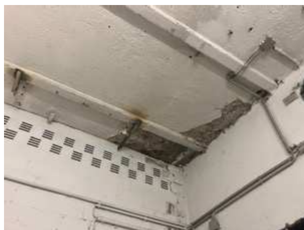
Massiver Feuchtigkeitseintrag im Untergeschoss
