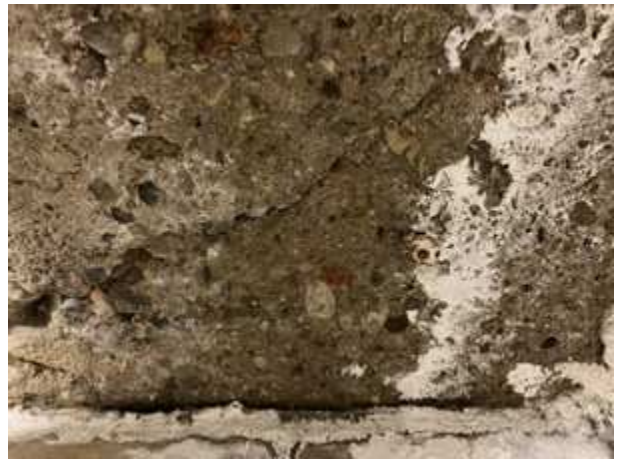
Deckenuntersicht: Detailaufnahme grobkörniger Beton mit starkem Rissbild.
