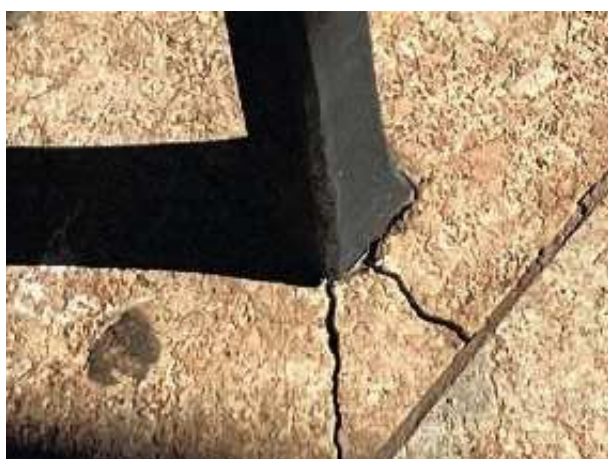
Rostsprengung an dem Brüstungsgeländer
