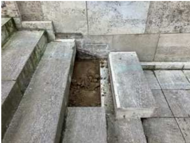
Ausgebaute Blockstufe
