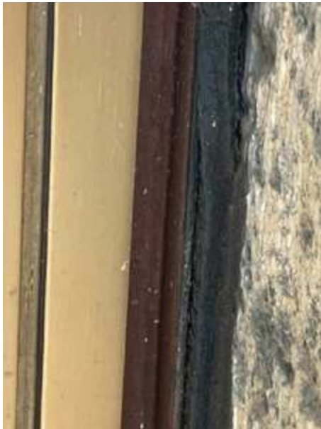
Seitlicher Anschluss mit defekter Dichtung
