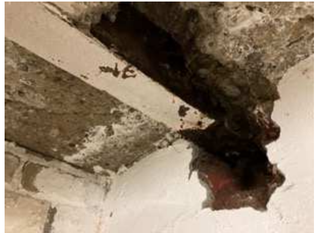
Bauteilöffnung: Freigelegter Stahlträger I180, Wandaufleger
