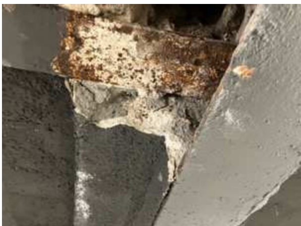
Bauteilöffnung: Freigelegter Stahlträger I180
