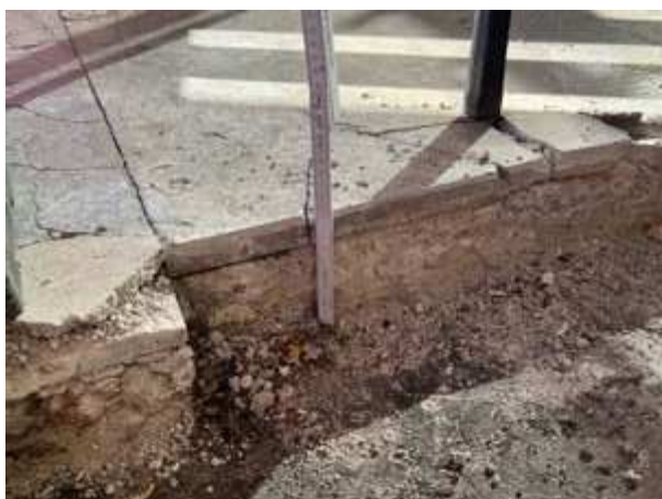
Bauteilöffnung: Aufbauhöhe Bodenbelag
