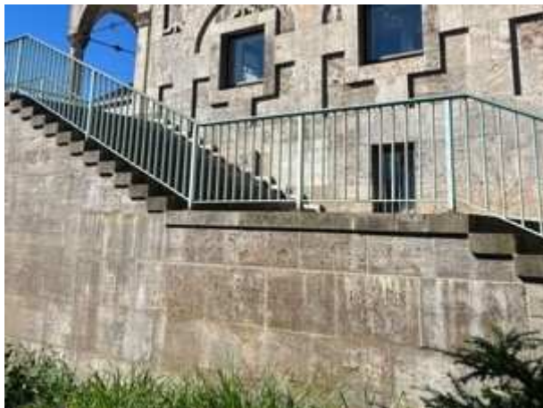
Starke Verfärbungen und Wasserläufer am Fugennetz
