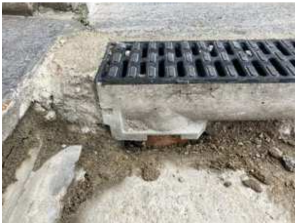
Bodenrinne ohne funktionierende Abdichtungseben
