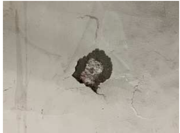
Putzabplatzung; starke Durchsalzung des Mauerwerks
