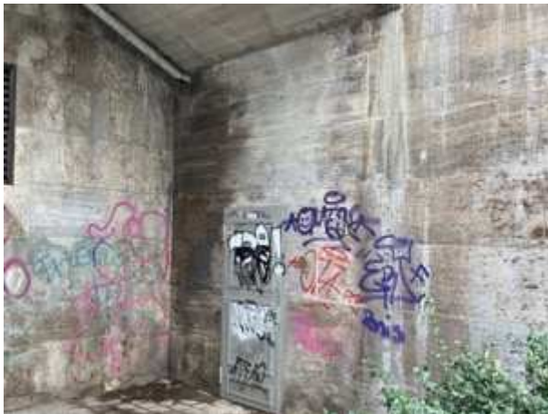
Starke Durchfeuchtung im Bereich des Bauteilanschlusses
