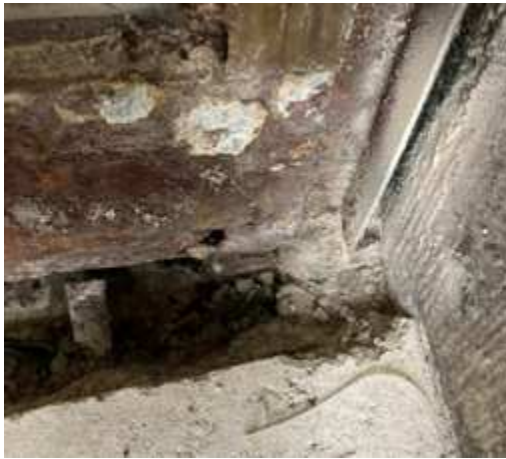
Unterkonstruktion, korrodierter Stahl
