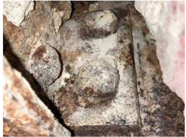
Bauteilöffnung: Verbindungsstück Neben- zu Hauptträger
