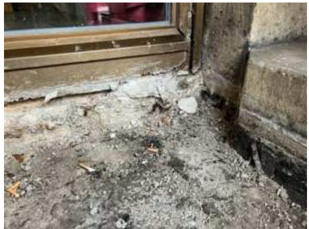
Bauteilöffnung: Defekte Schwelle der Stahl-Glas-Fassade ohne Abdichtung
