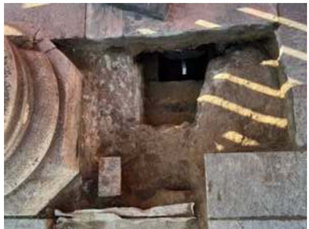
Bauteilöffnung: Übergang Arkadengang / Gehweg / Fußpunkt der Säule
