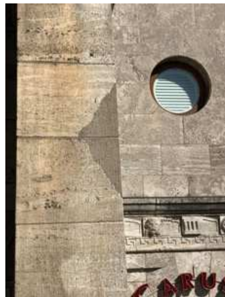
Antragung an der Pilasterecke
